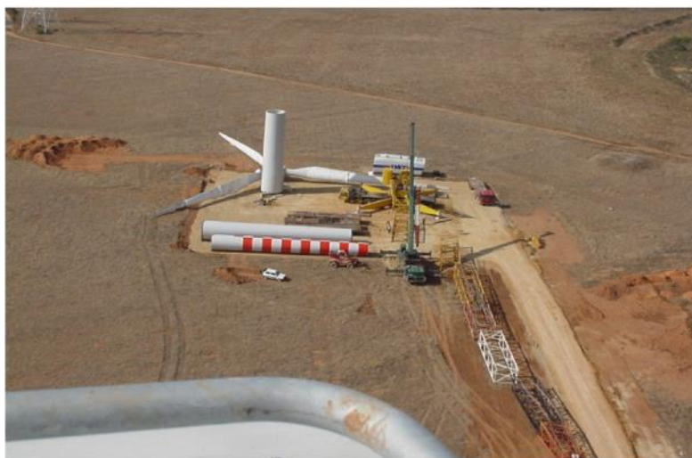
Figura 51 – Piazzola per il montaggio dell'aerogeneratore
