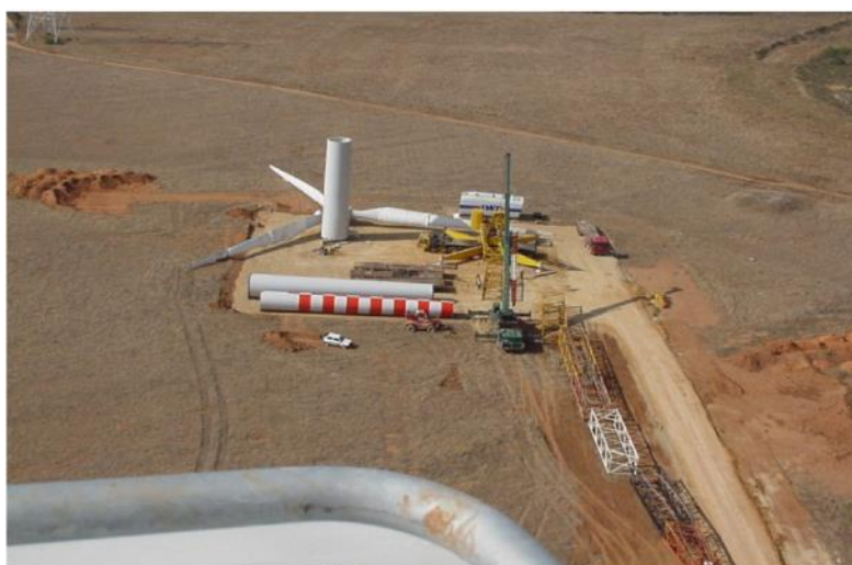
Figura 19 – Piazzola per il montaggio dell'aerogeneratore
