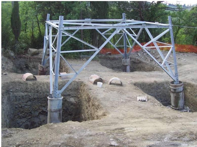
**Foto 9 - Esempio di fondazione di un sostegno**
