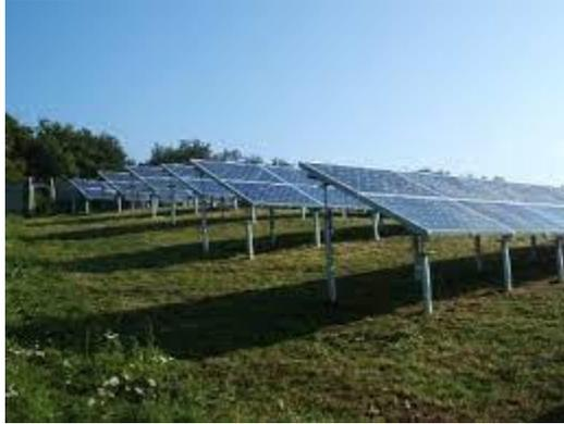
Figura 17 – Vista struttura fissa statica per moduli fotovoltaici
