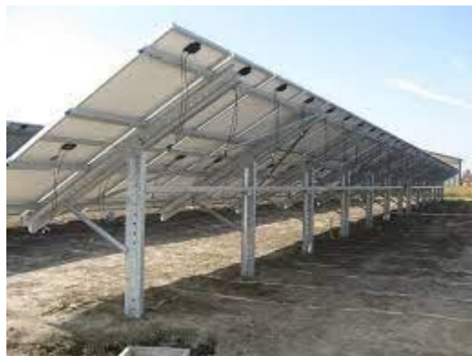
Figura 5.11-3: Vista struttura fissa statica per moduli fotovoltaici
