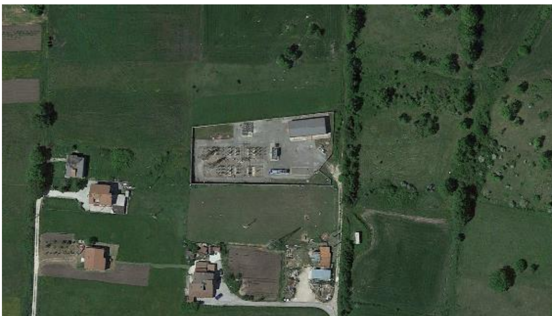
Figura 5.6-2: sottostazione esistente di Terna di connessione 36kV ed elevazione 150kV
