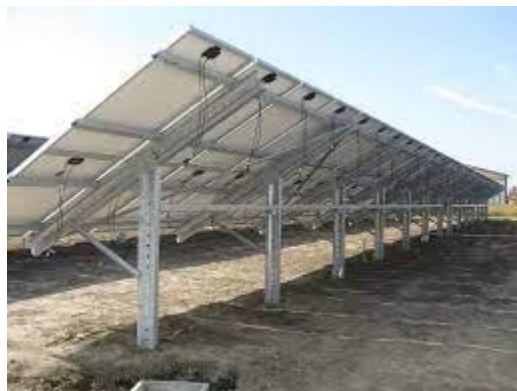
Figura 3.13-3: Vista struttura fissa statica per moduli fotovoltaici
