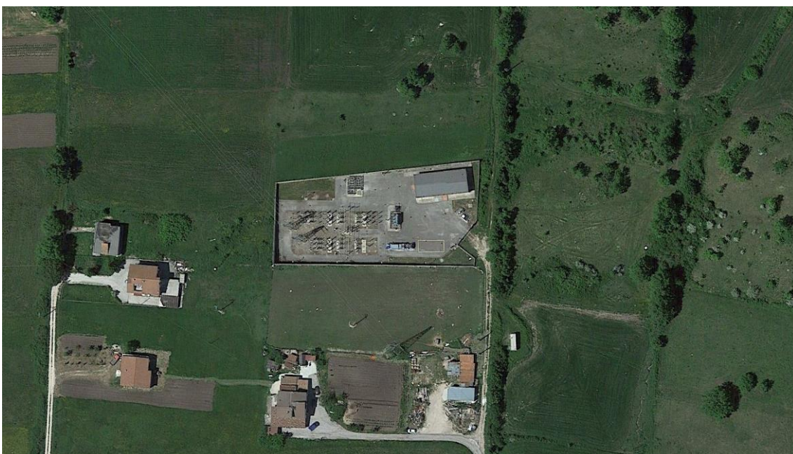
Figura 3.8-2: sottostazione esistente di Terna di connessione 36kV ed elevazione 150kV
