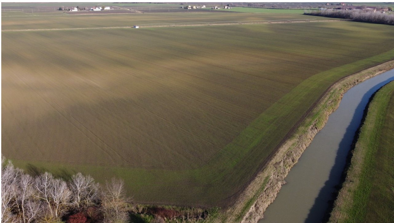
Figura 36 - Punto di osservazione 1 pre-intervento
