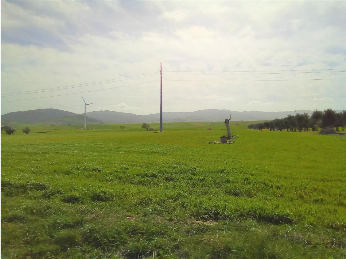
Punto terminale del cavidotto A.
