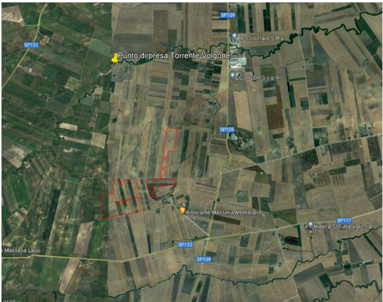
Punto di ripresa fotografica lungo il torrente Volgone a 1,7 km di distanza dalle aree di progetto
