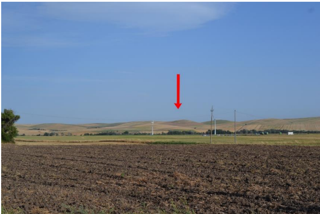
Individuazione della posizione delle aree di progetto dal punto di ripresa lungo SP 131 (a 3km)
