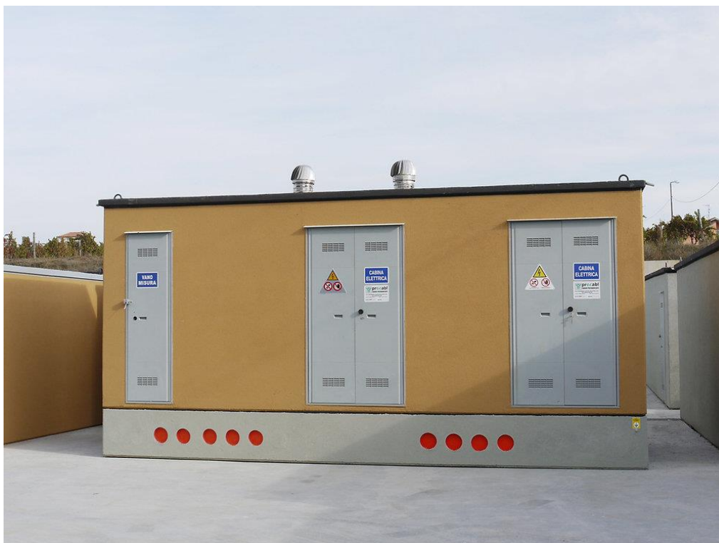
Cabina Prefabbricata pronta all'installazione in sito.
