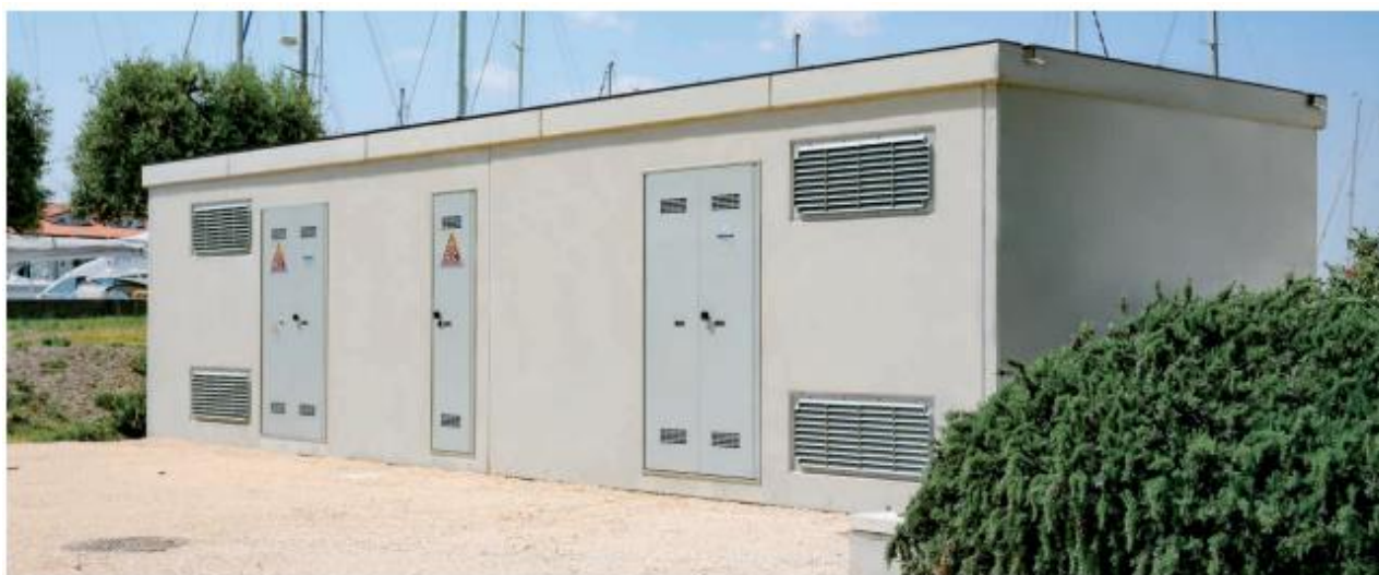
Cabina Prefabbricata installata
