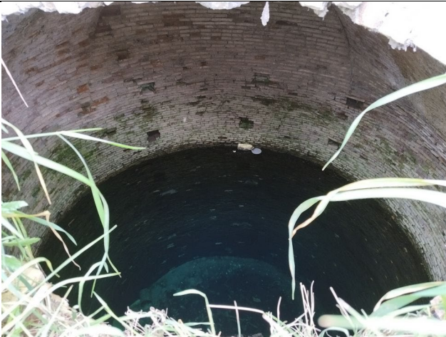
Foto 11. Vista dell'interno di pozzo "Canneto".
