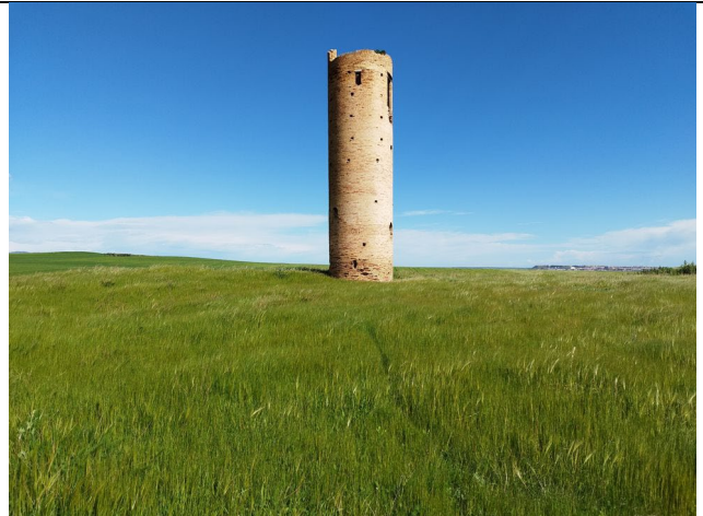
Foto 6. Torre di avvistamento sita a ovest di Mass. Montaratro
