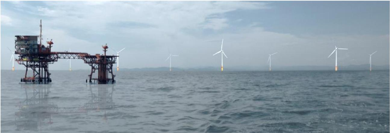
L'intervento CENTRALE EOLICA OFFSHORE "RIMINI" (330 MW)" antistante la costa tra Rimini e Cattolica, prevede 51 aerogeneratori della potenza di 6,45 MW (per 330 MW complessivi) e opere di collegamento alla RTN (Rete di Trasmissione Nazionale), con punto di connessione alla Stazione TERNA "San Martino in Venti" ubicata in comune di Rimini.
