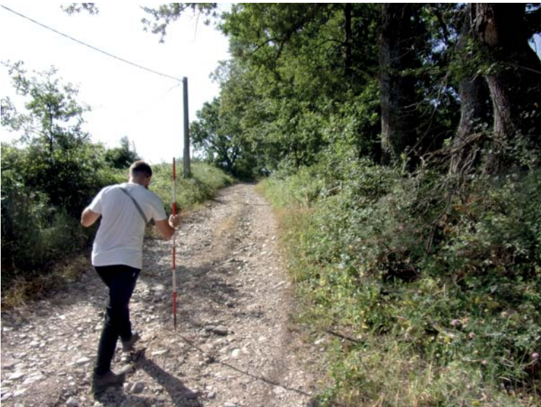
cavidotto direzione T1
