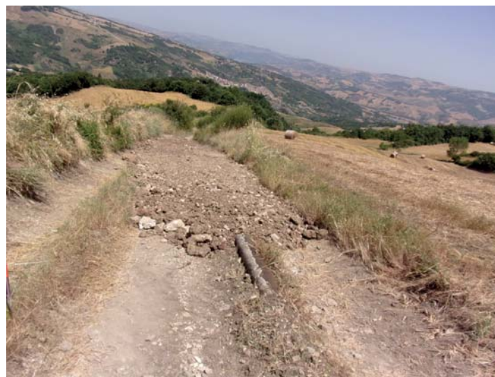
cavidotto direzione T8
