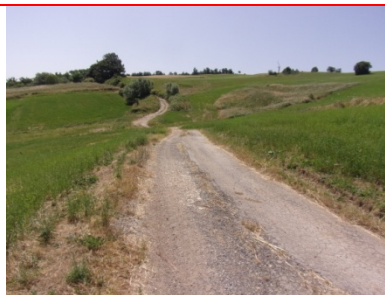
Fig. 11, cavidotto direz. T6 visto da ovest
