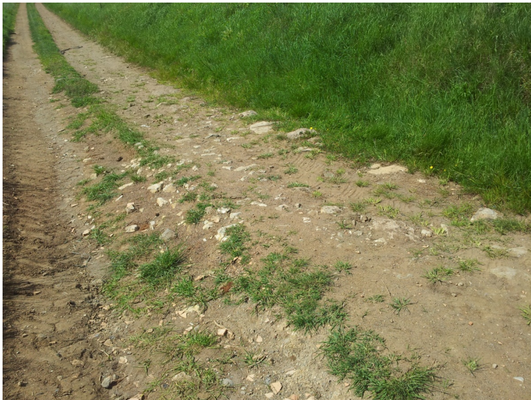
Fig. 3.1-3 Sito 3, Il tratto di strada pavimentata coperta dalla terra e la vegetazione, sulla destra le pietre più grandi corrispondenti alle crepidini. (aprile 2013)
