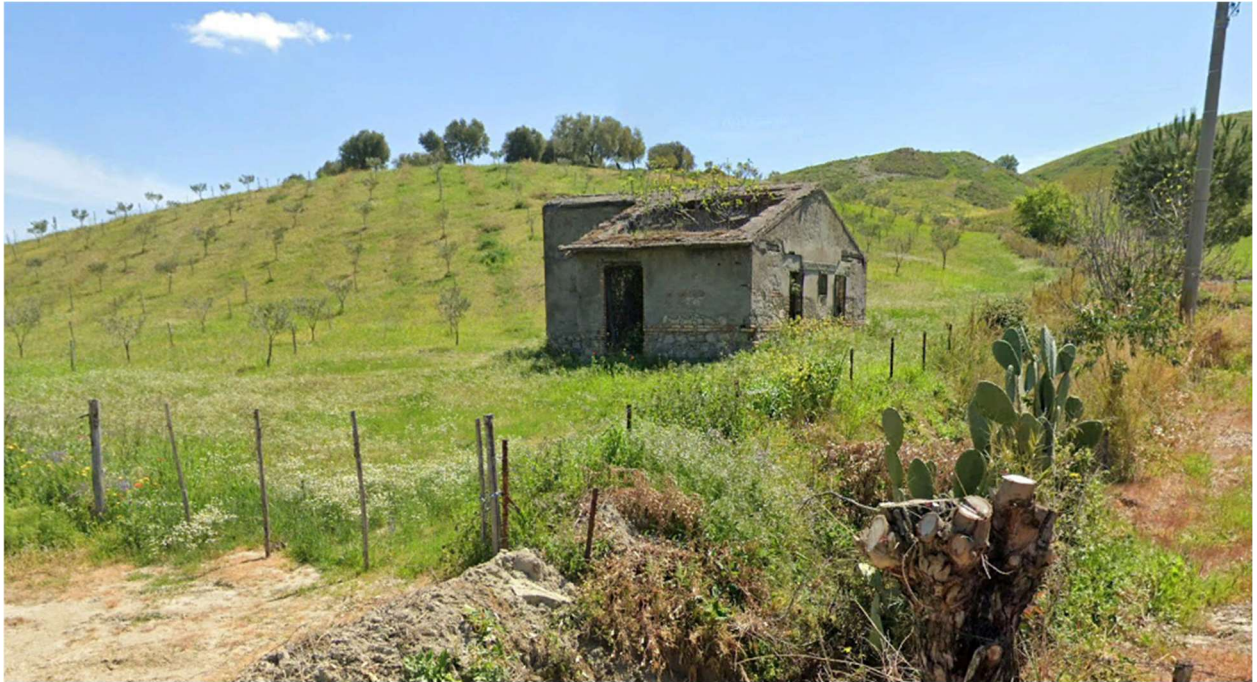
Figura 5: Vista della posizione del fabbricato n. 1
