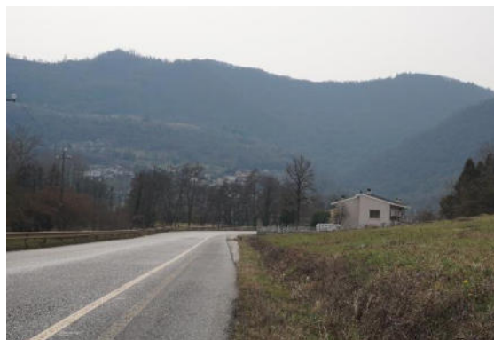
Figura 3.8-2: Via Vallugana utilizzata dai mezzi di cantiere
