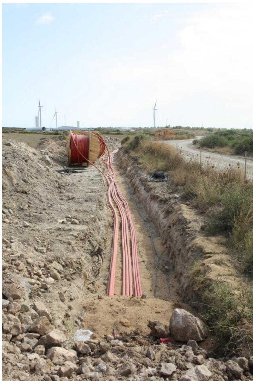
*Figura 6.6 - Tipico scavo e linee MT interrato*
