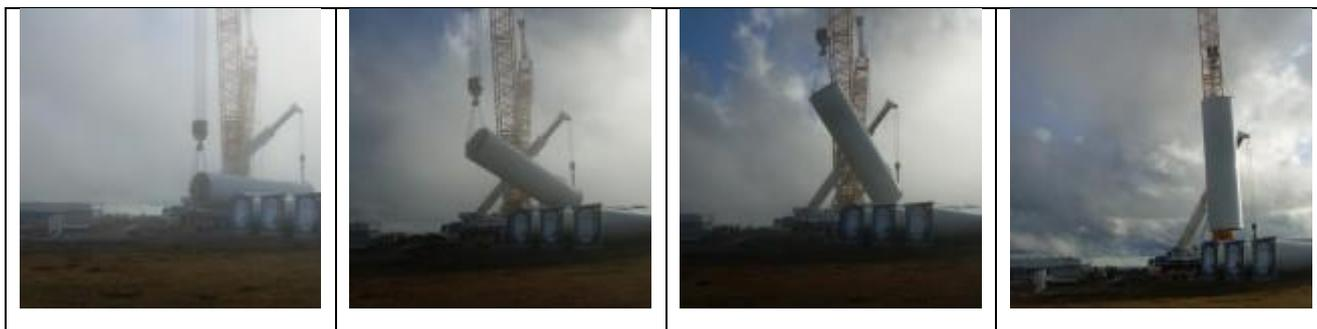
Figura 5.28 – Schema delle fasi di sollevamento dei componenti dell'aerogeneratore (Fonte sito web <http://www.windfarmbop.com/> )
