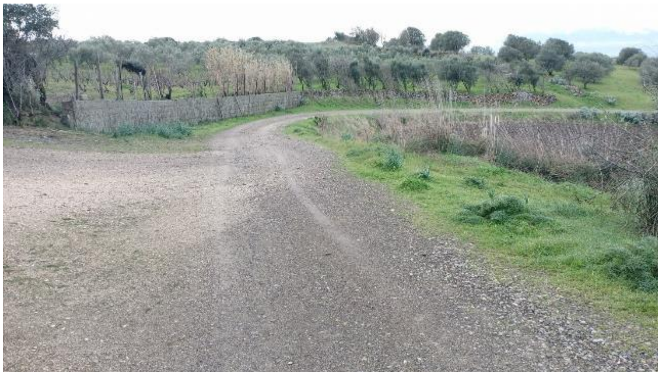
Figura 9.12 Ac -Esistente strada rurale di accesso alle postazioni eoliche SR02 e SR01 che sarà oggetto di adeguamento (Direzione sud- ovest)
