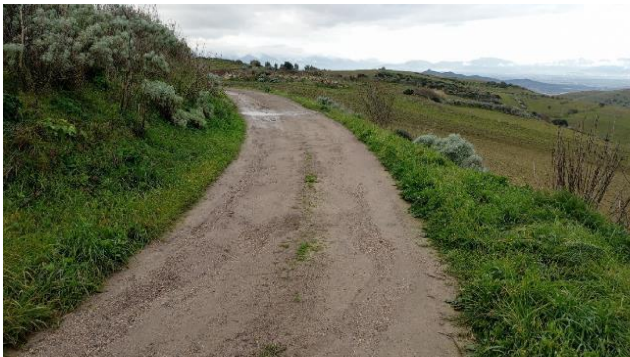
Figura 9.16 - Tracciato da adeguare in direzione della postazione eolica SR02 (direzione sud-ovest)
