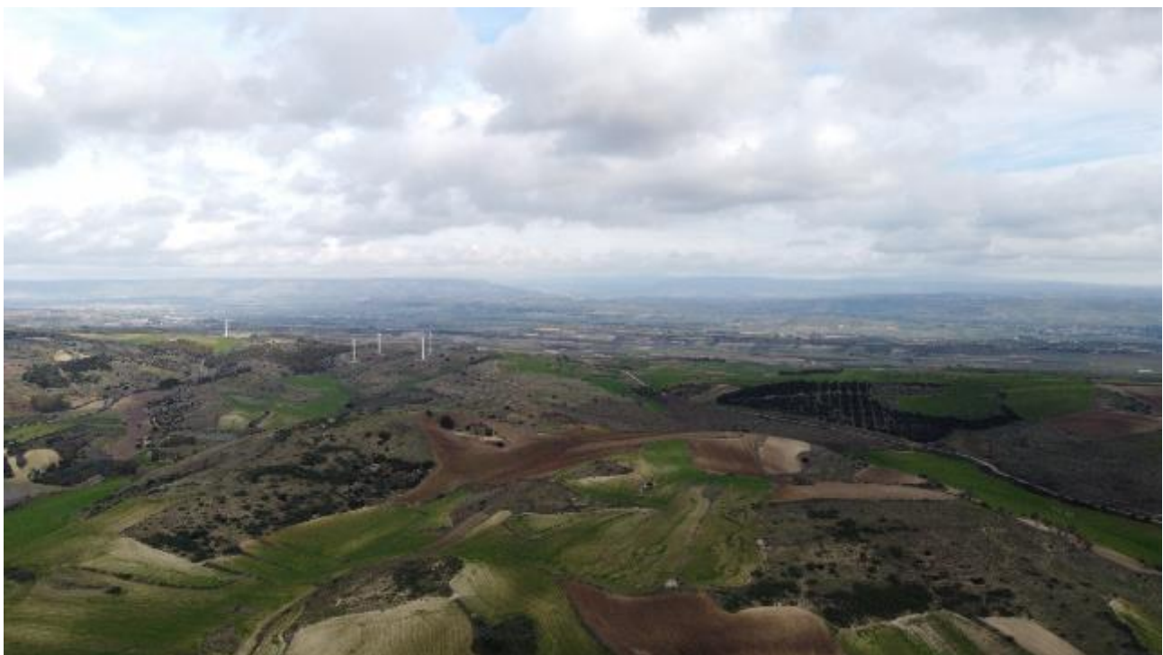
Figura 6.13 - Sito di installazione delle postazioni eoliche SR07 e SR08, nella porzione meridionale dell'impianto. Ripresa aerea da sud-ovest verso nord-est
