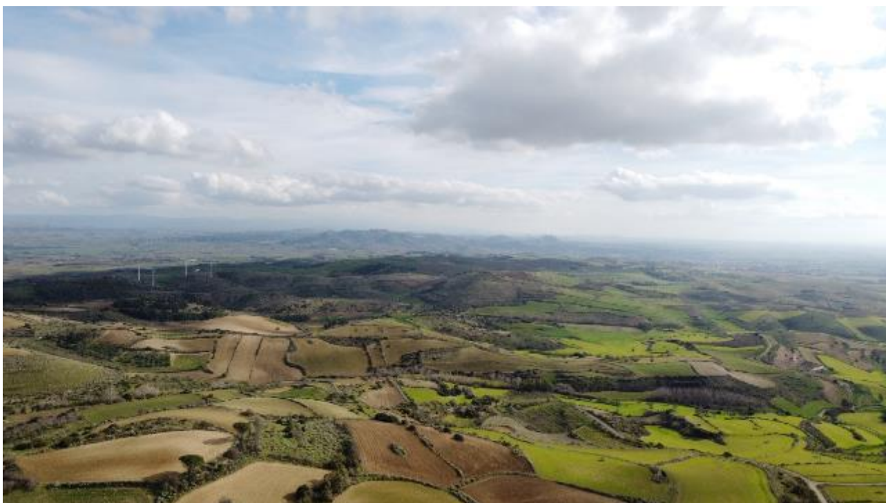
Figura 6.11 – Veduta dell'area di installazione dell'aerogeneratore SR05. Ripresa aerea da ovest verso est
