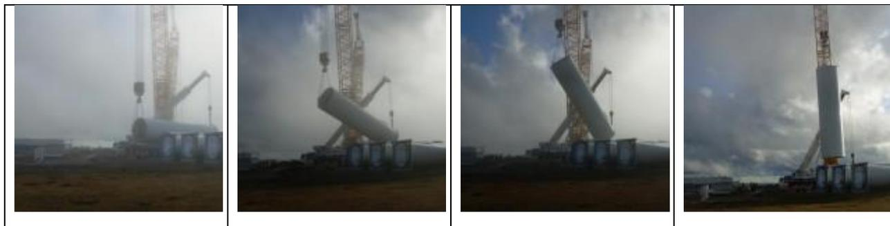
Figura 5.31 – Schema delle fasi di sollevamento dei componenti dell'aerogeneratore (Fonte sito web <http://www.windfarmbop.com/> )
