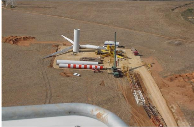
Figura 2 – Piazzola per il montaggio dell'aerogeneratore
