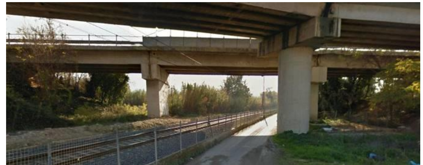
FIG. 10 – SOTTO-ATTRAVERSAMENTO CVF RAMPA DI RACCORDO DELL’AUTOSTRADA A25
