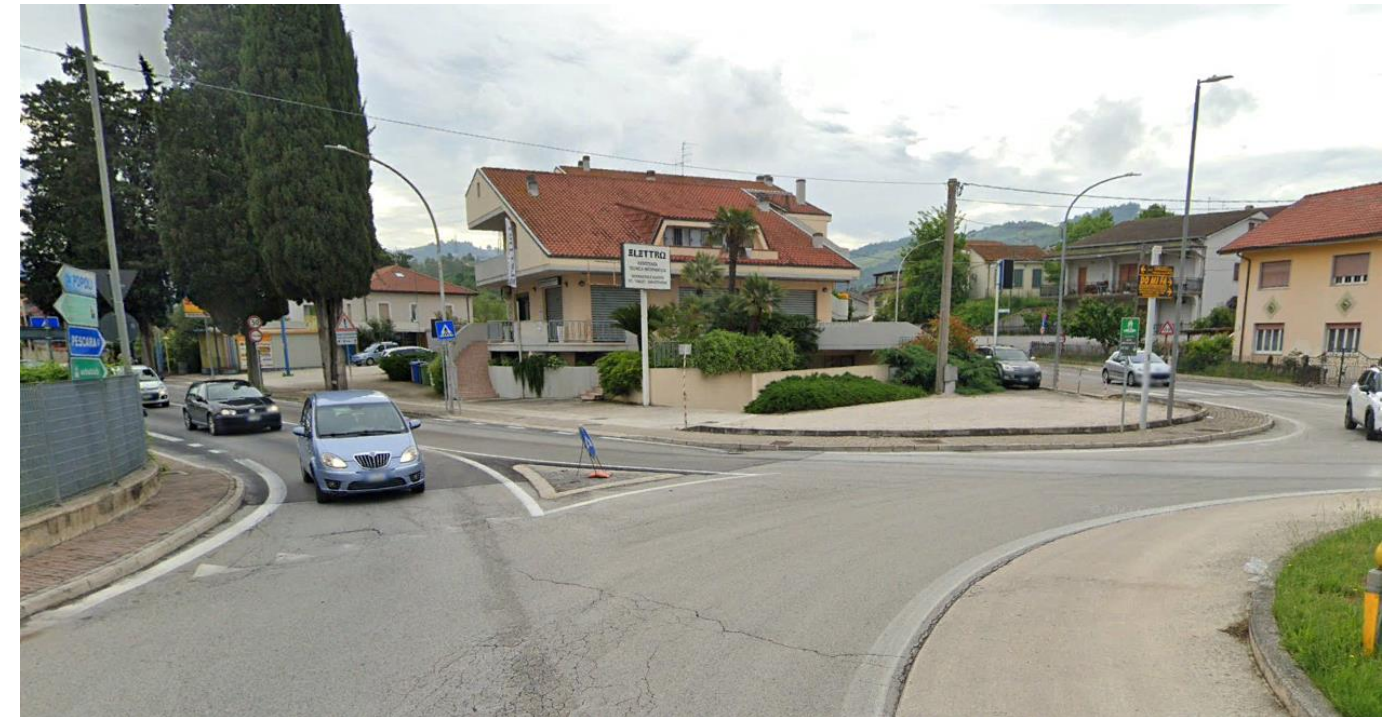
FIGURA 31 FRAZIONE BRECCIAROLA, CHIETI – EDIFICATO RESIDENZIALE
