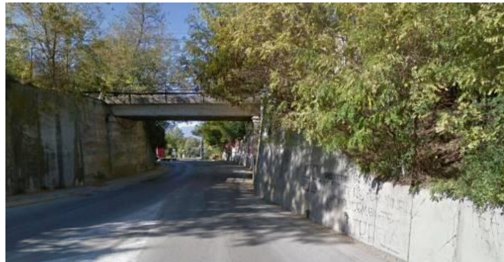
FIG. 8 – PONTE ATTUALE SU VIA TIRINO
