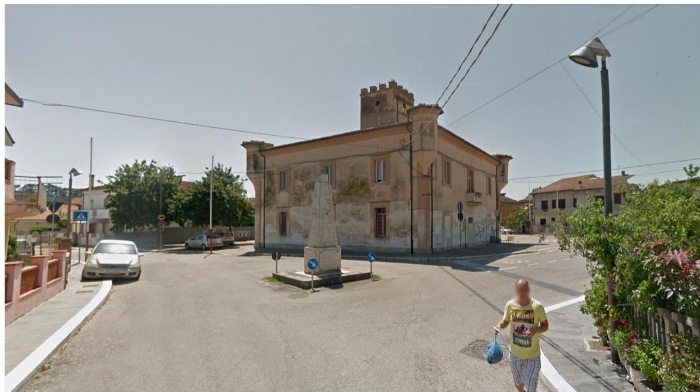
FIGURA 30 FRAZIONE BRECCIAROLA, CHIETI - EDIFICIO FORTIFICATO
