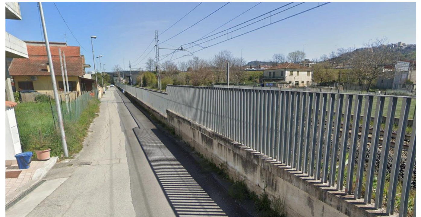
FIGURA 34 FRONTE URBANO LUNGO L’ASSE FERROVIARIO PRESSO VIA GIUSEPPE VERDI - MANOPPELLO SCALO
