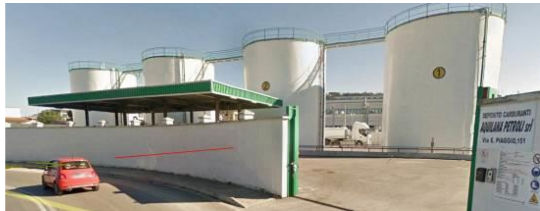
FIG. 4 – DEPOSITO CARBURANTE ESISTENTE AL KM 13+400 CIRCA
