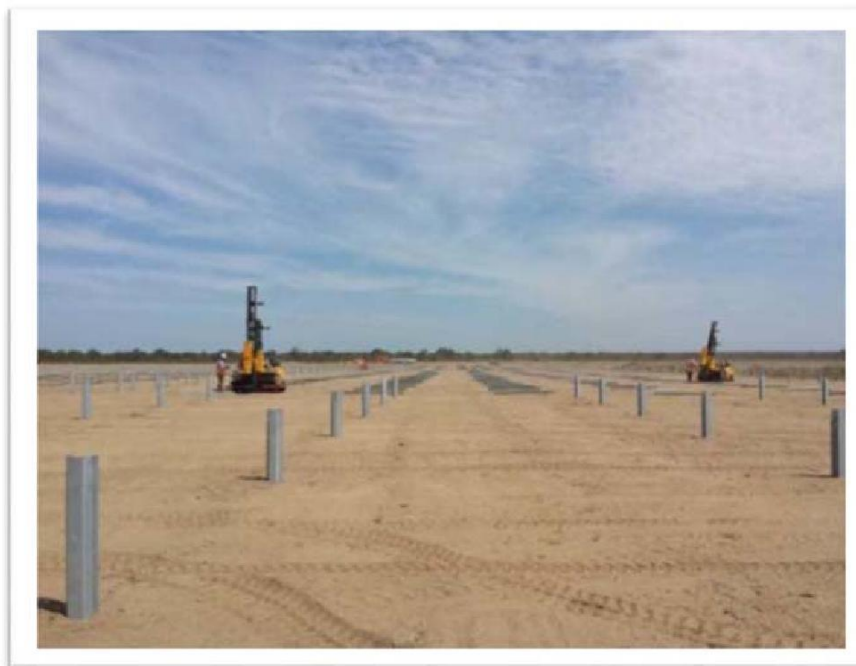
Figura 13 - Foto esempio di impianti realizzati con stessa struttura e stessi moduli fotovoltaici
