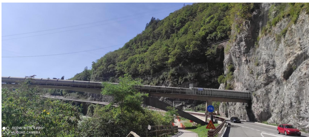
Parete di scavo In corrispondenza dell'imbocco in galleria del Ponte Tubo sul F. Piave
