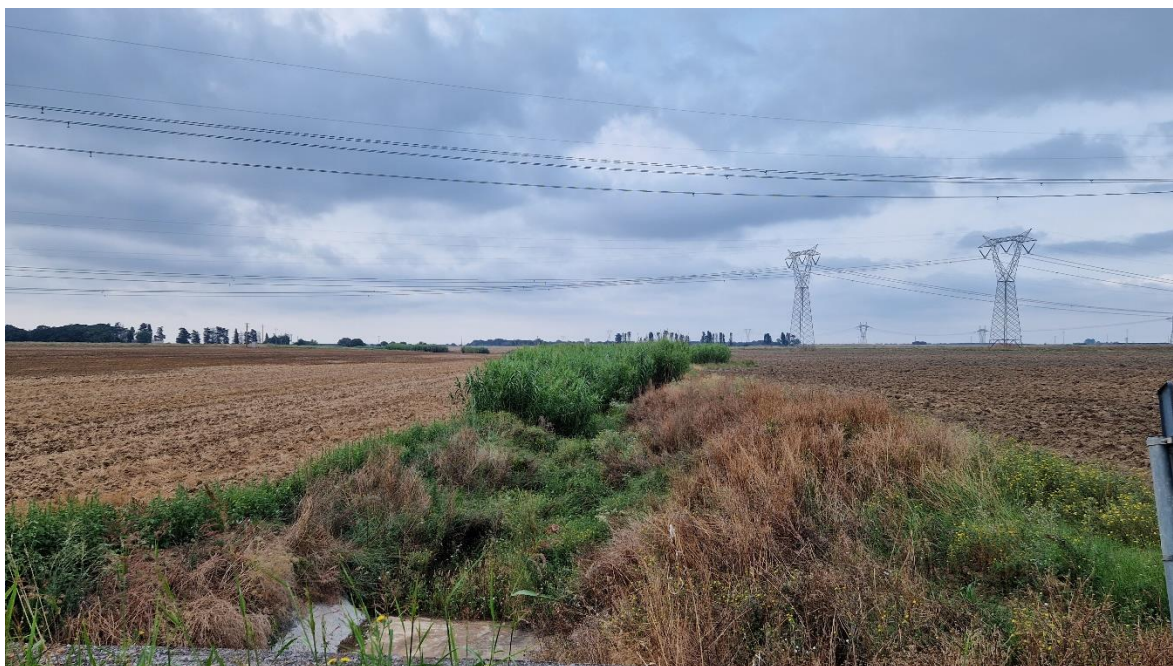
FOTO 17 – Viabilità lungo la quale interrare il cavidotto
