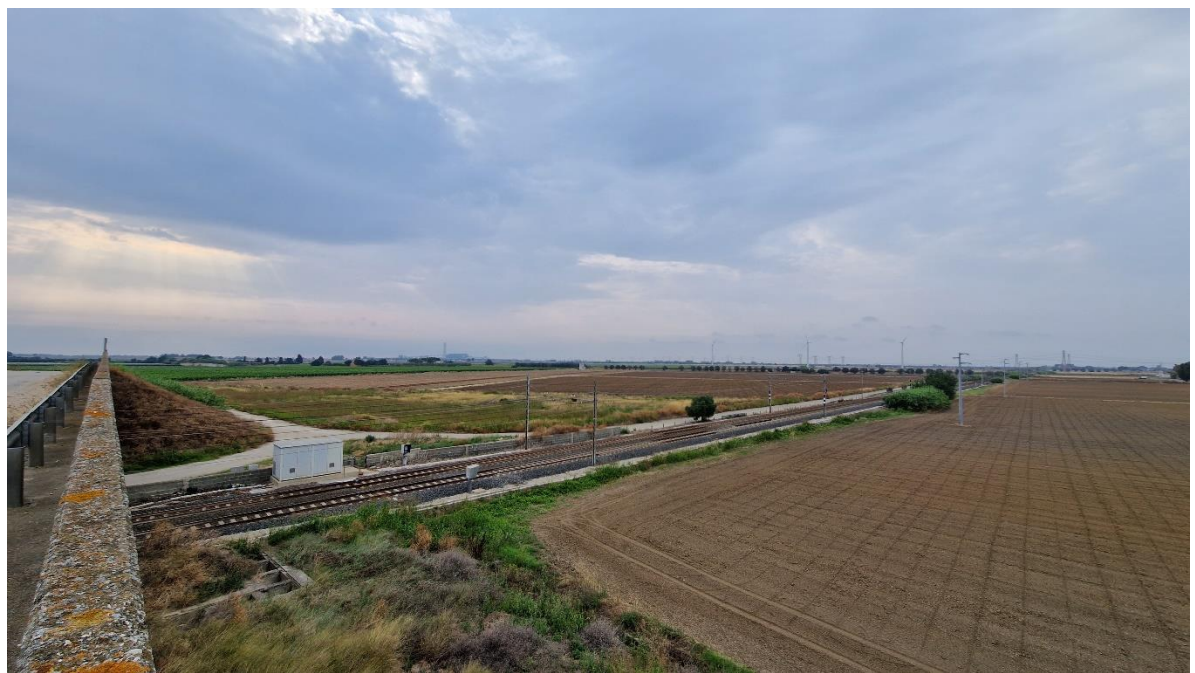
Foto 4 - area di intervento
