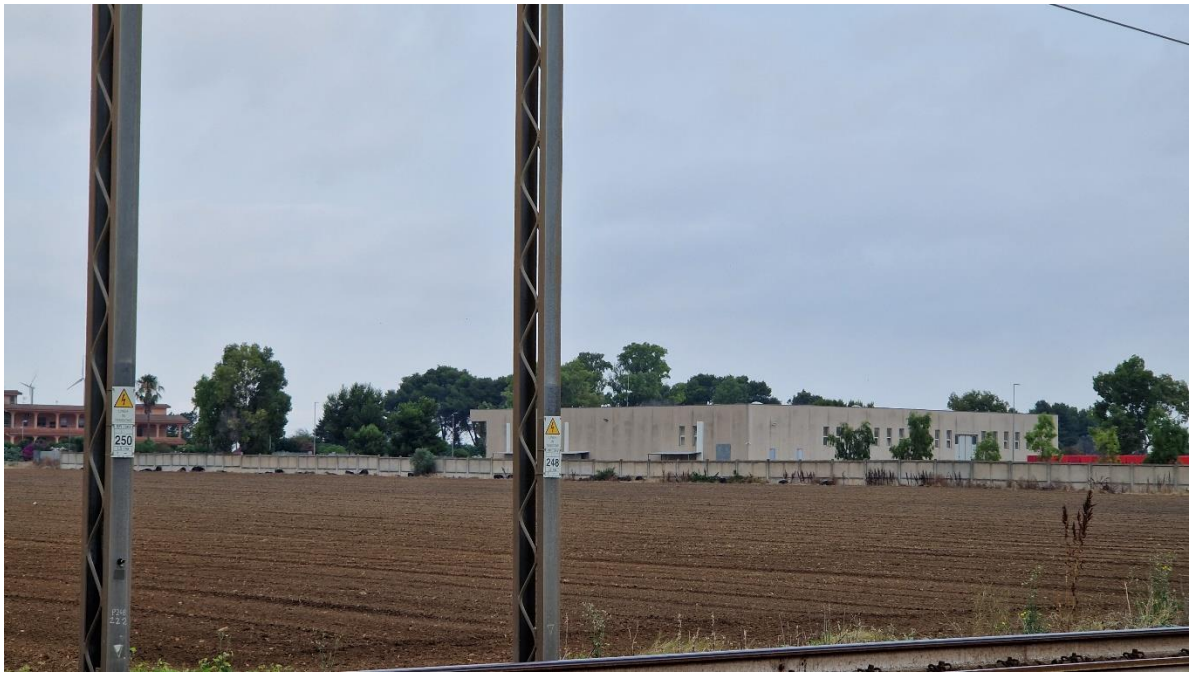
FOTO 11 – area di intervento
