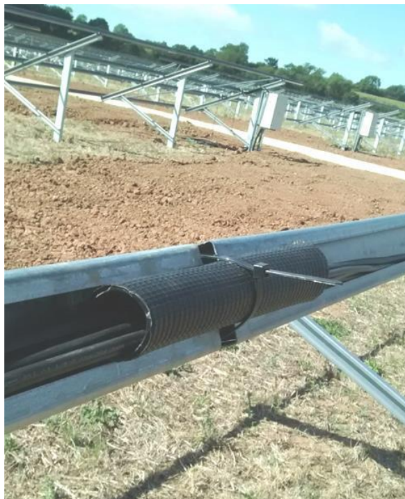
Figura 10 – Cablaggio stringhe
