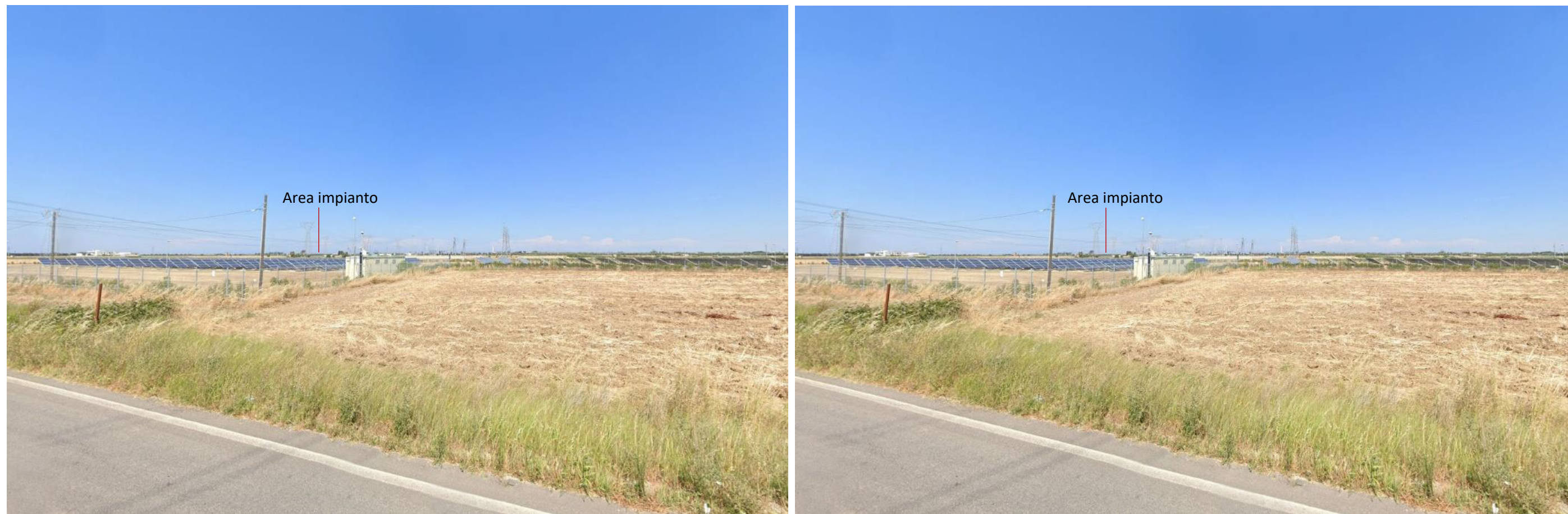
Figura 15 - Punto di scatto 6 in prossimità del bene architettonico “Masseria Moina” verso l’area d’impianto (ubicazione dell’impianto in progetto è indicato in rosso). Ante operam a sinistra e Post operam a destra – Impianto non visibile
