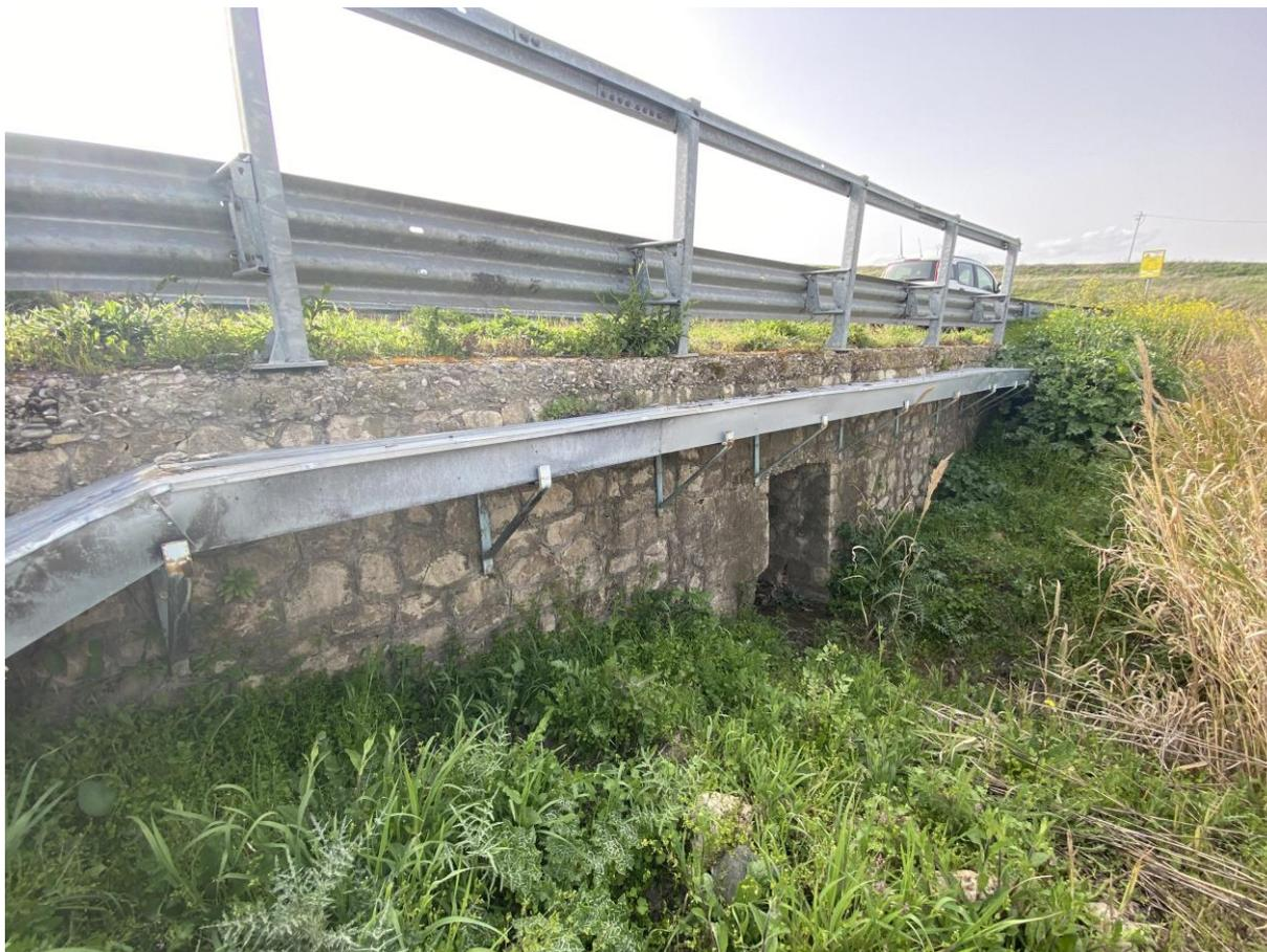
**Figura 27: Particolare di uno staffaggio su struttura esistente**
