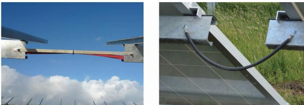
Figura 7: Collegamento equipotenziale tra strutture adiacenti
