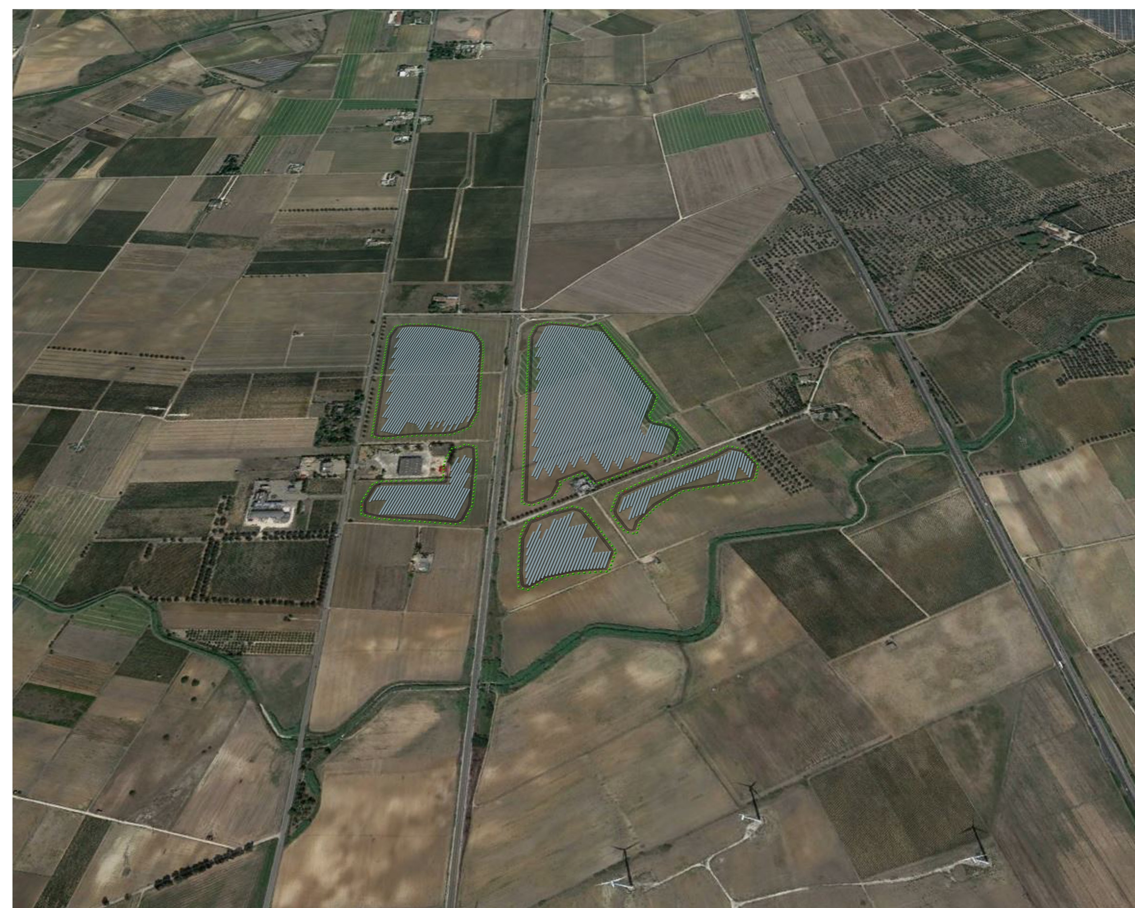
VISTA DA NORD - AREA DI IMPIANTO
