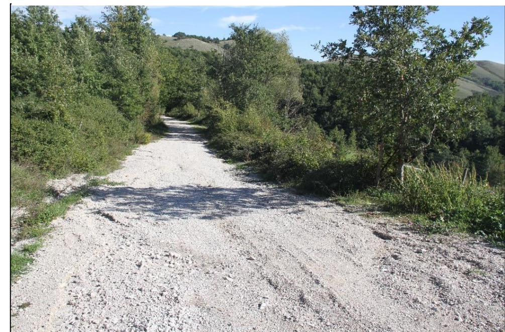
Figura 3.30: Visuale 2 - Strada sterrata che conduce all'Area Pozzo Pergola 1
