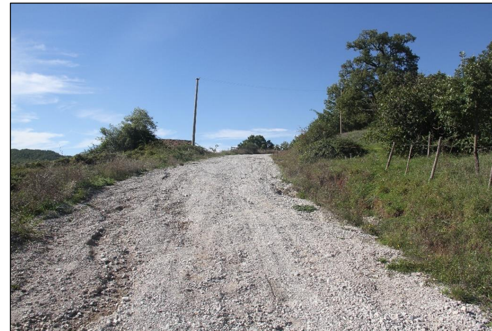
Figura 3.32: Visuale 3 - Strada sterrata che conduce all'Area Pozzo Pergola 1 e sulla quale verrà posizionata la condotta
