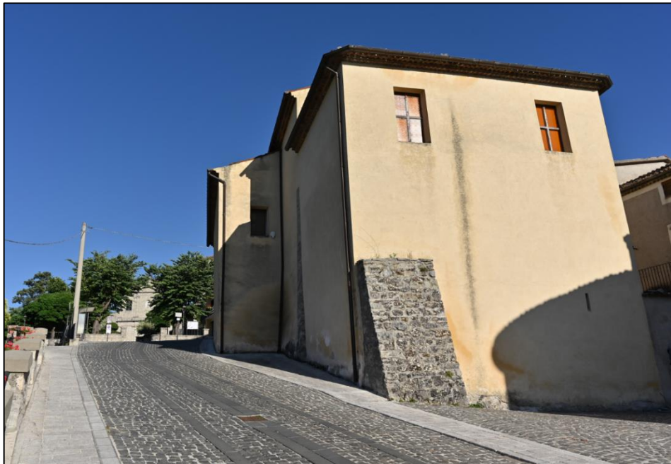
Figura 3.19: vista della chiesa di S. Michele Arcangelo da via San Basile
