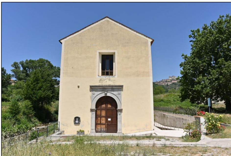
Figura 3.22: facciata della chiesa di S. Maria di Costantinopoli
