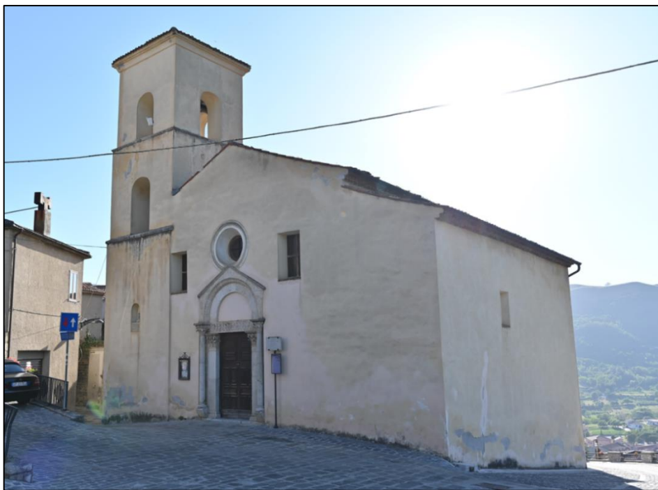
Figura 3.18: vista della facciata di S. Michele Arcangelo da via San Basile
