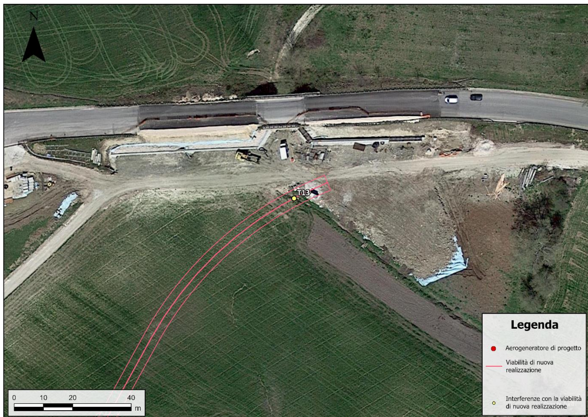
Figura 7.14: Interferenza T13, tra la viabilità di accesso alla torre MU28 e l'idrografia.
