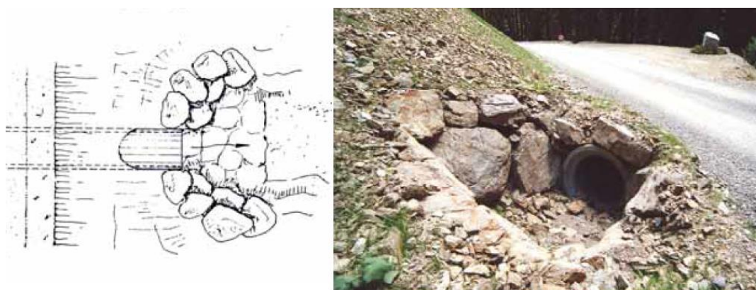
Figura 6.16: Pozzetti in legname e in massi (fonte: "Viabilità forestale regionale" Bortoli, P.L. 2001).
