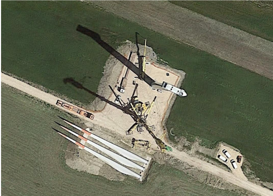
Figura 4.9: esempio di piazzola in fase di costruzione
