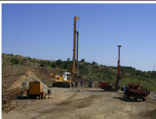
Realizzazione pali trivellati
