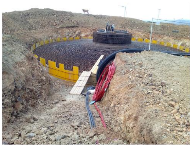
Posa ferri e cassetatura
