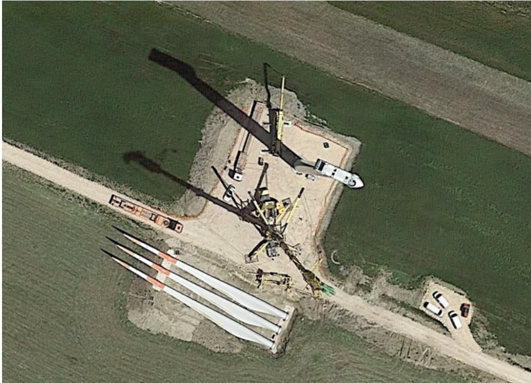
Figura 4.6 – esempio di piazzola in fase di costruzione
