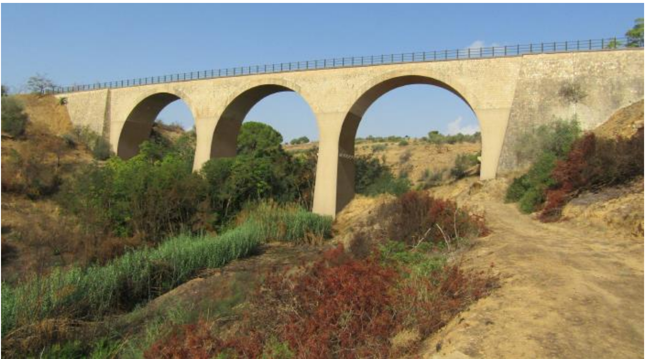
Figura 6 . – Intervento su Viadotto VI04 – post operam - (stralcio Elaborato RS6K00R22EXIM0002002A)
