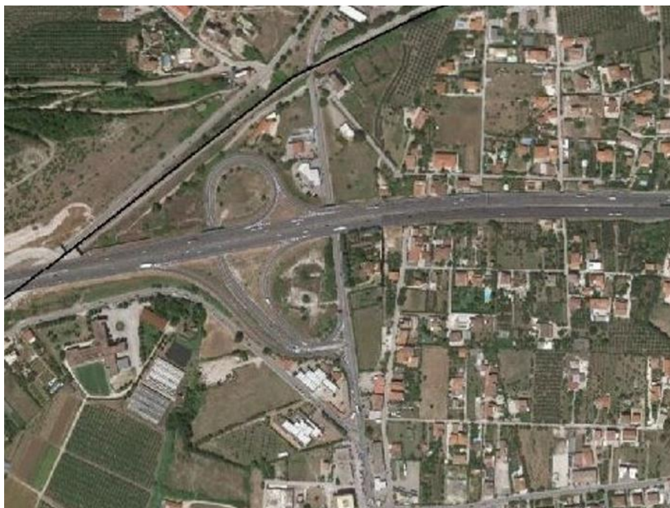
Figura 10 – Foto area dello svincolo oggetto di adeguamento
