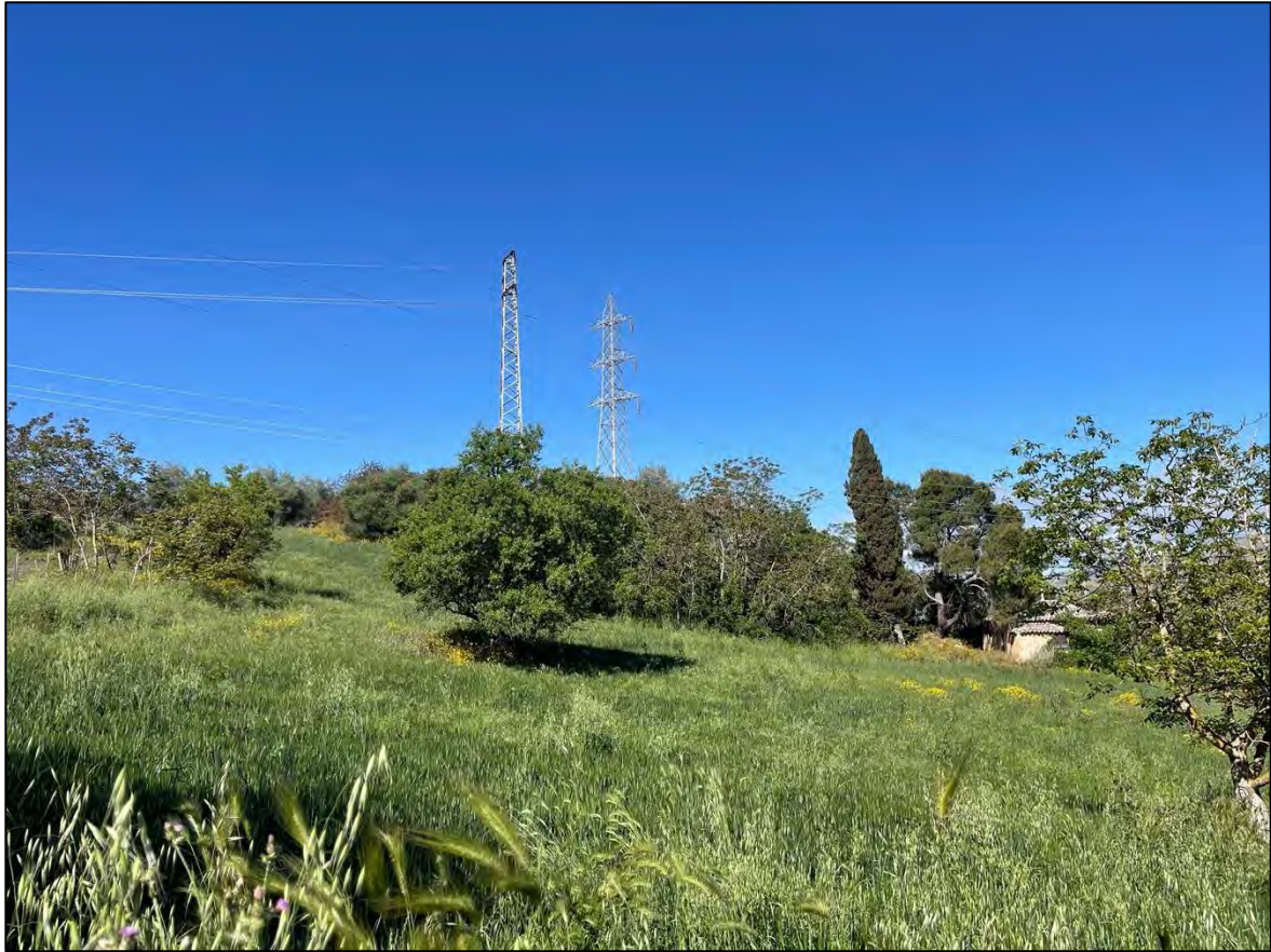
Foto 115: Panoramica UR 65 (sostegno P.56A)
