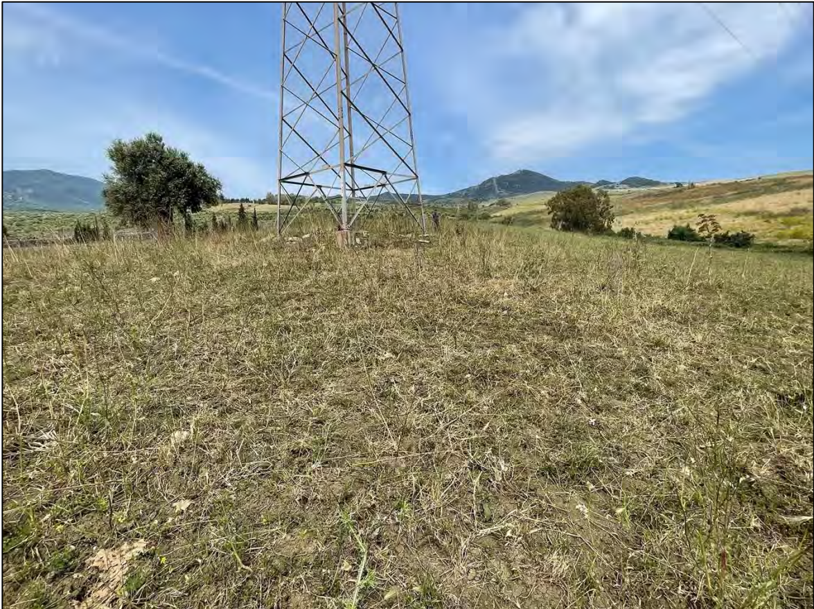
Foto 70: Panoramica UR 29 (sostegno P.349A)
