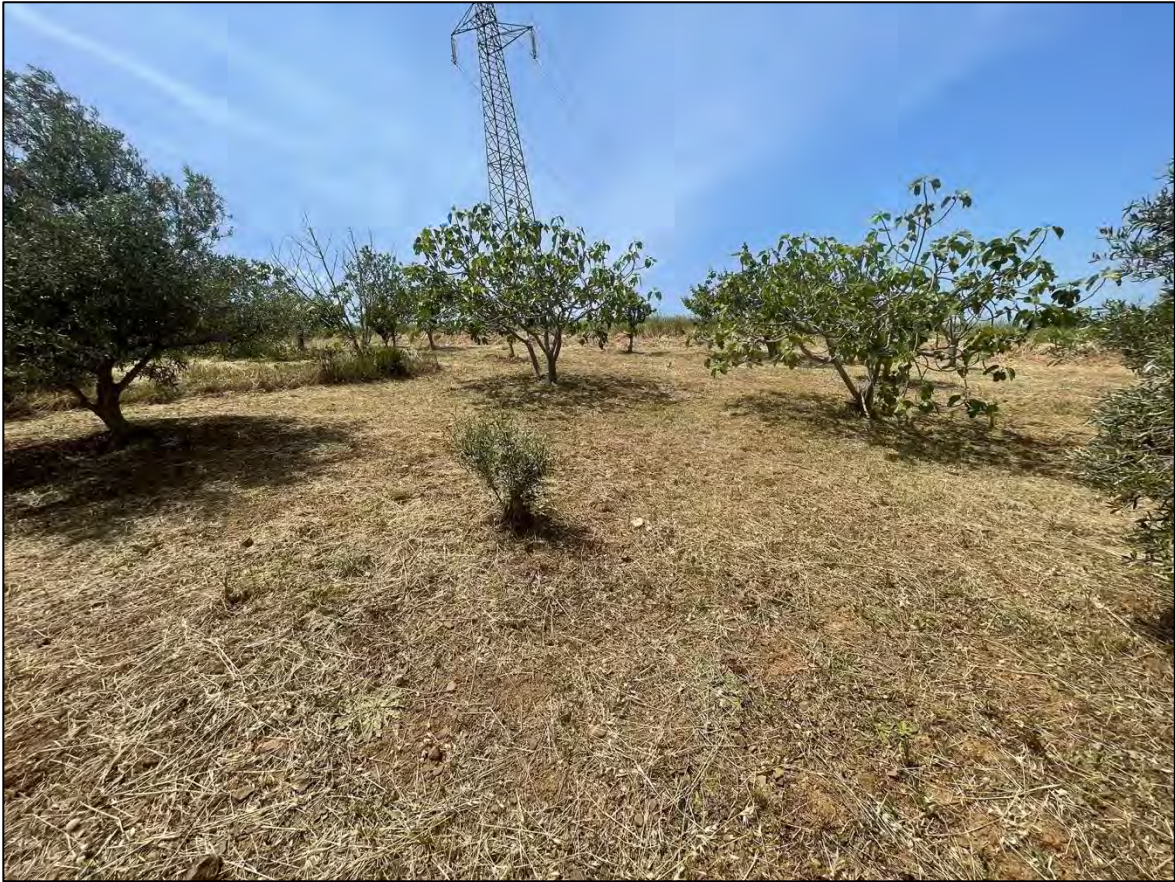
Foto 79: Panoramica UR 36 (sostegno P.336A)
