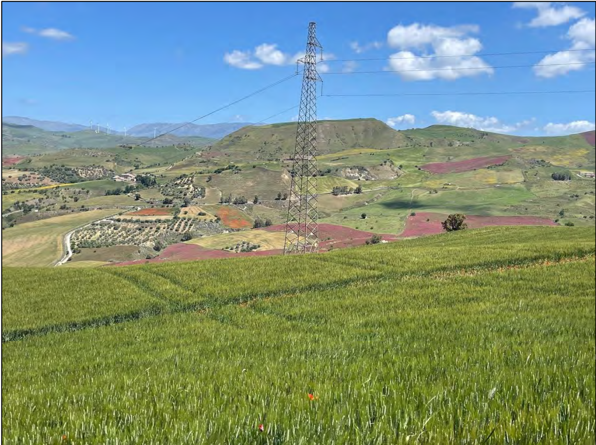
Foto 108: Panoramica UR 59 (sostegno P.36A)
