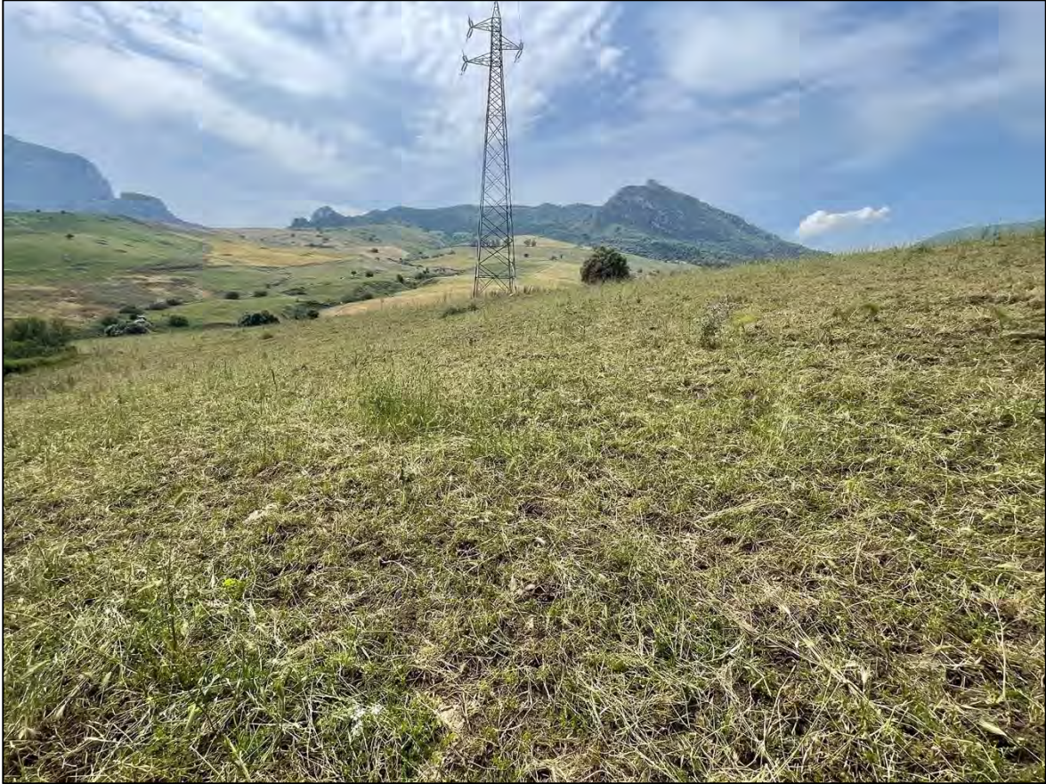
Foto 69: Panoramica UR 29 (sostegno P.349A)
