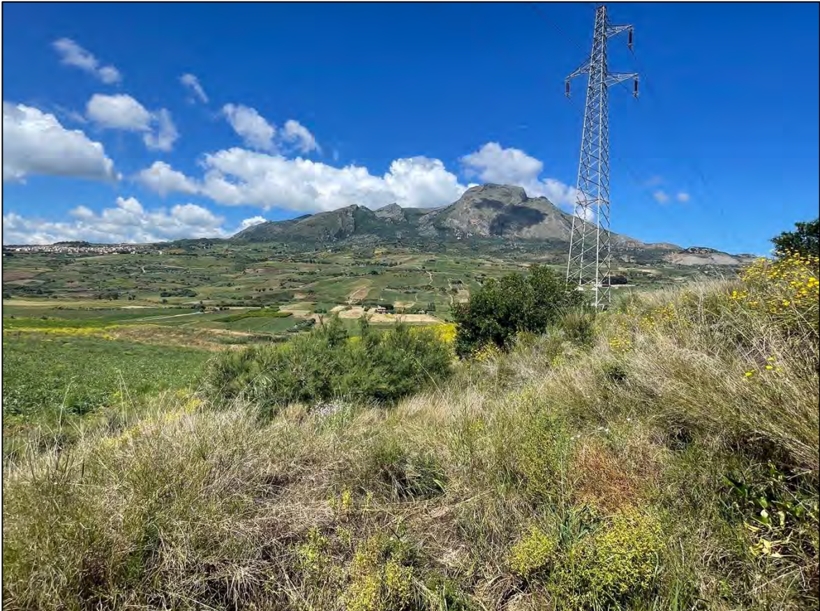
Foto 48: Panoramica UR 12 (sostegno P.374A)
