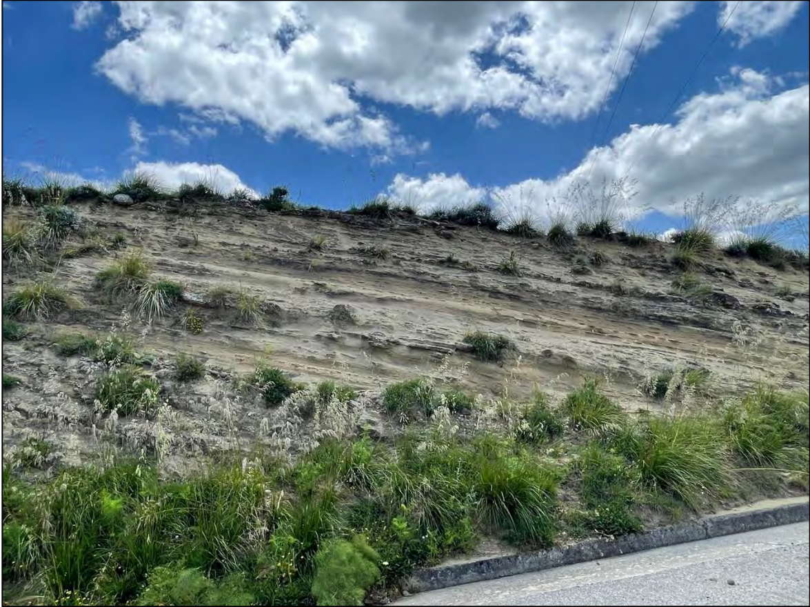
Foto 103: Panoramica UR 54 (sostegno P.25A)
