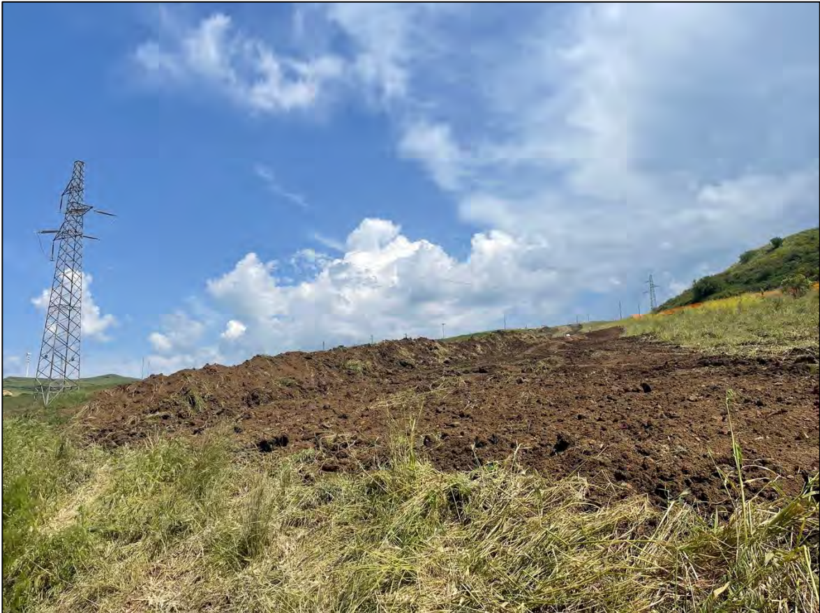
Foto 84: Panoramica UR 38 (sostegno P.334A)
