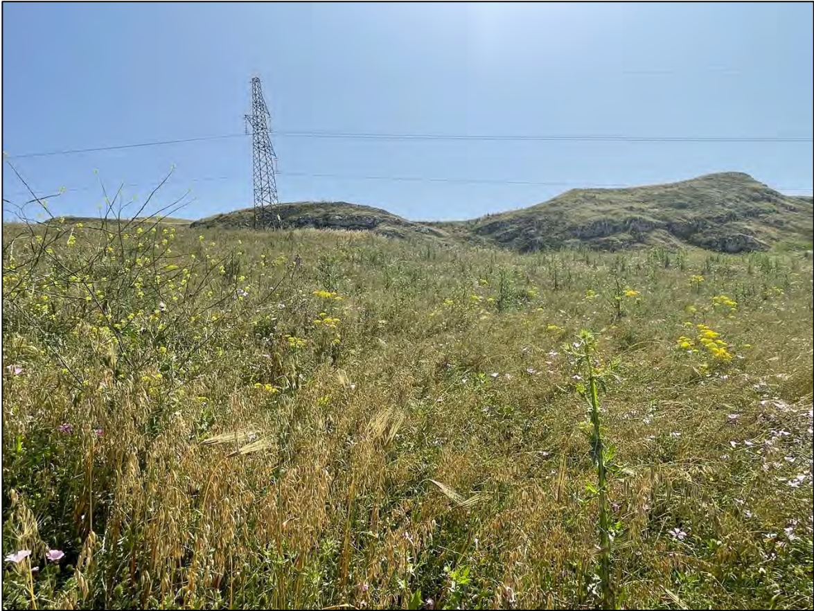
Foto 93: Panoramica UR 46 (sostegno P.13A)
