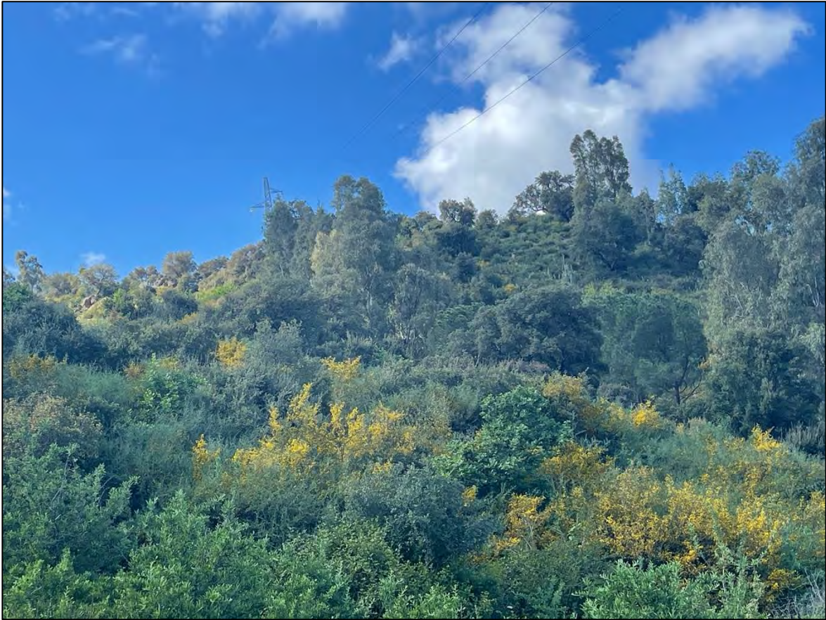
Foto 65: Panoramica UURR 24-25 (sostegni P.358A e P.357A)
