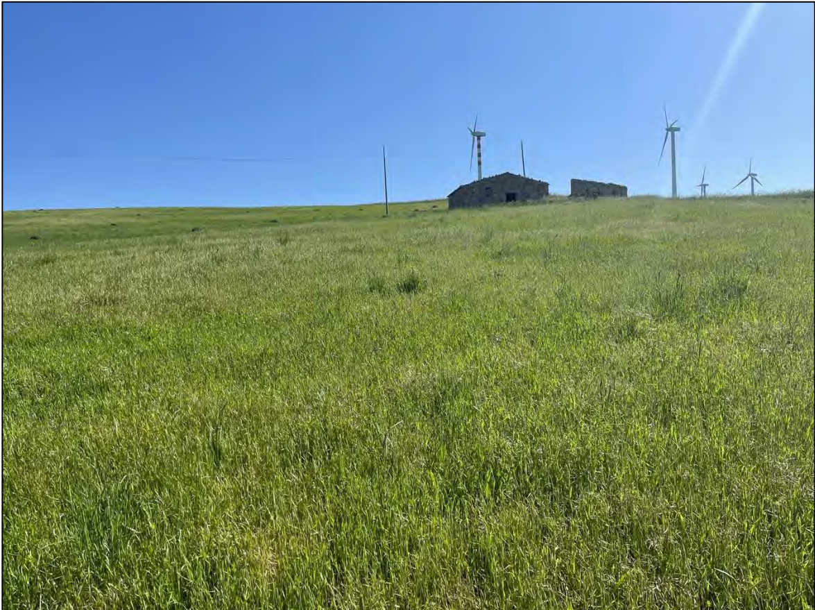
Foto 28: Panoramica UR 07 (aerogenerat.)
