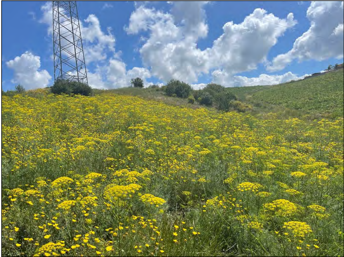
Foto 49: Panoramica UR 12 (sostegno P.374A)
