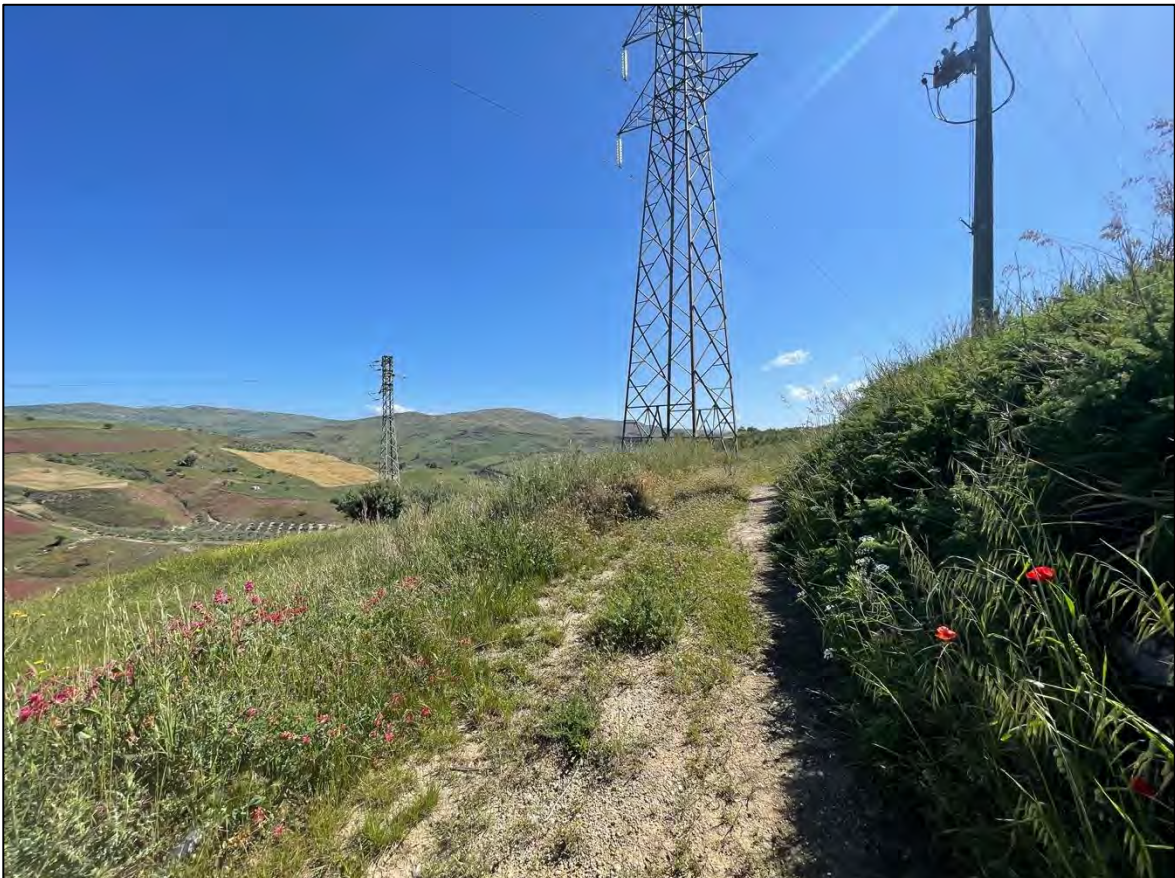
Foto 112: Panoramica UR 62 (sostegno P.52A)
