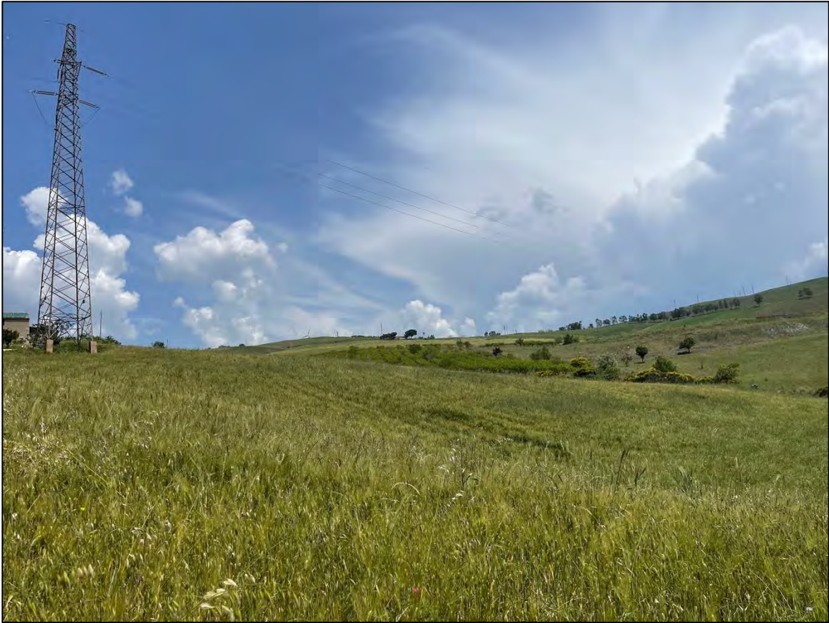
Foto 81: Panoramica UR 37 (sostegno P.335A)
