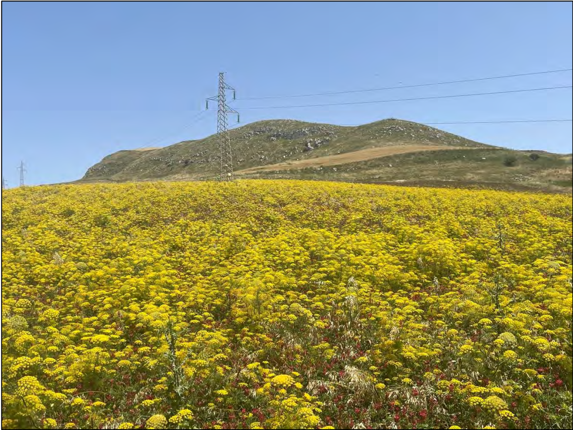
Foto 97: Panoramica UR 48 (sostegno P.16A)
