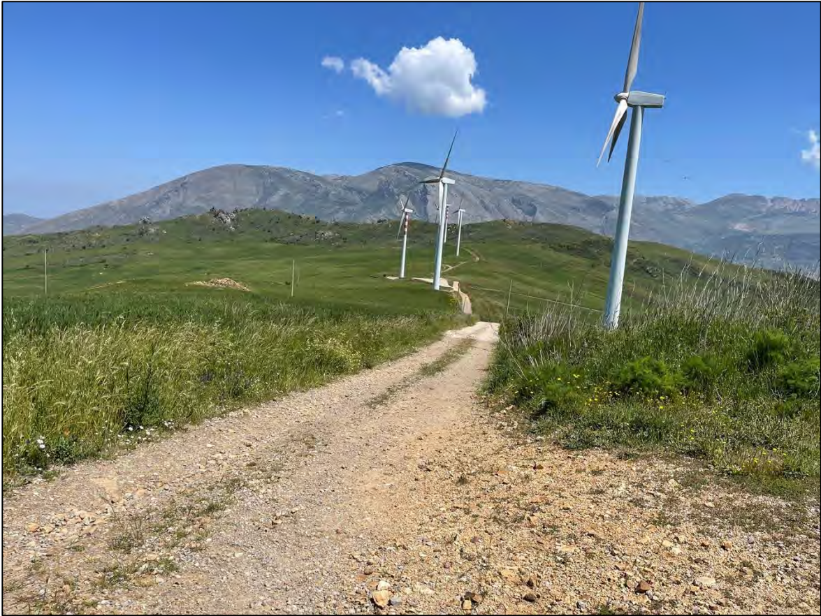
Foto 11: Panoramica UR 03 (viabilità e cavidotti)
