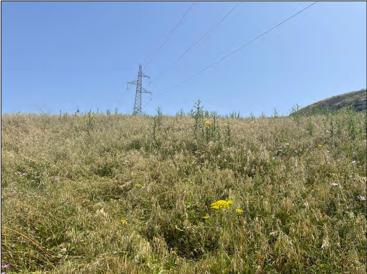
Foto 94: Panoramica UR 46 (sostegno P.13A)
