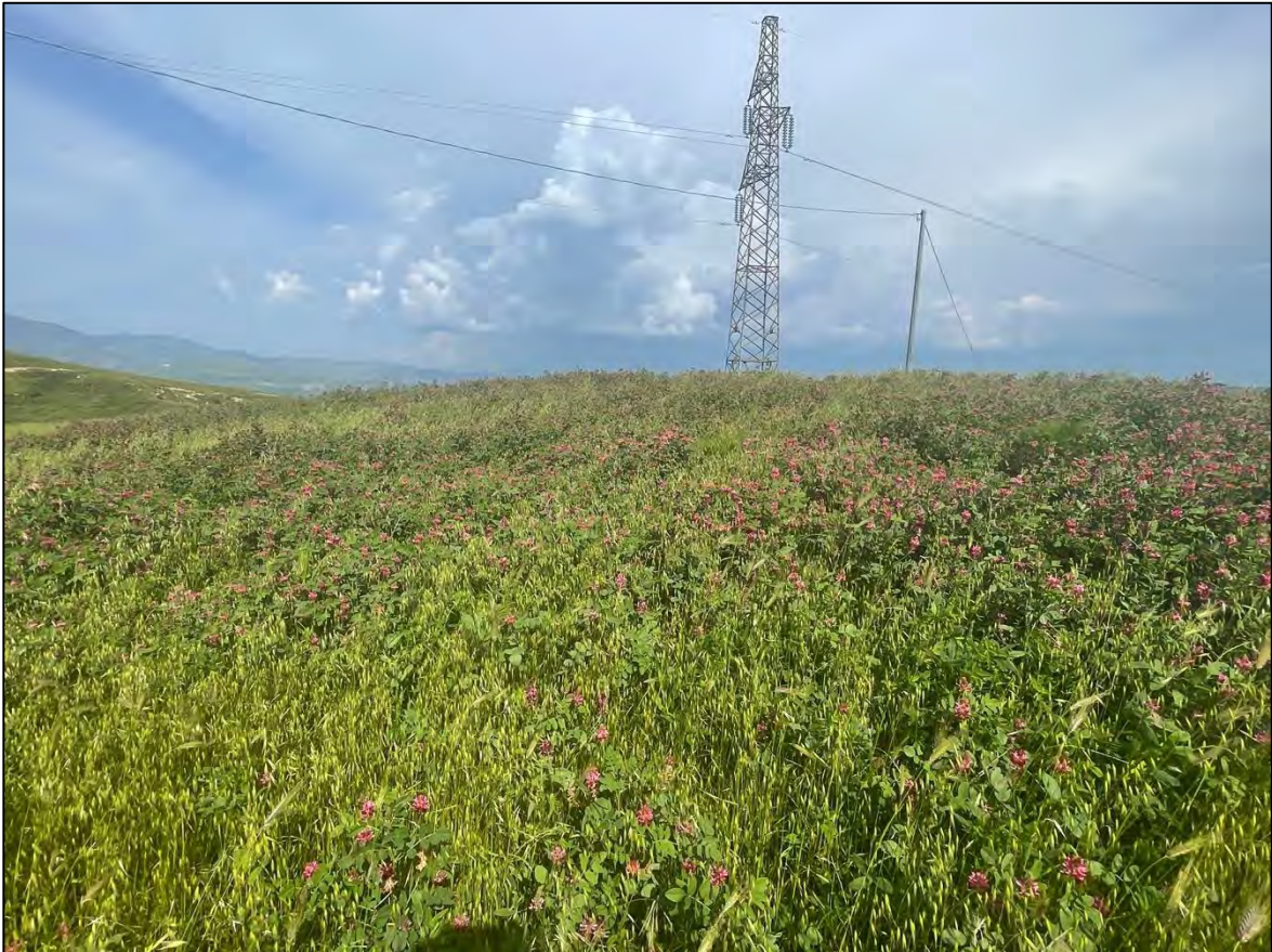
Foto 90: Panoramica UR 43 (sostegno P.7A)
