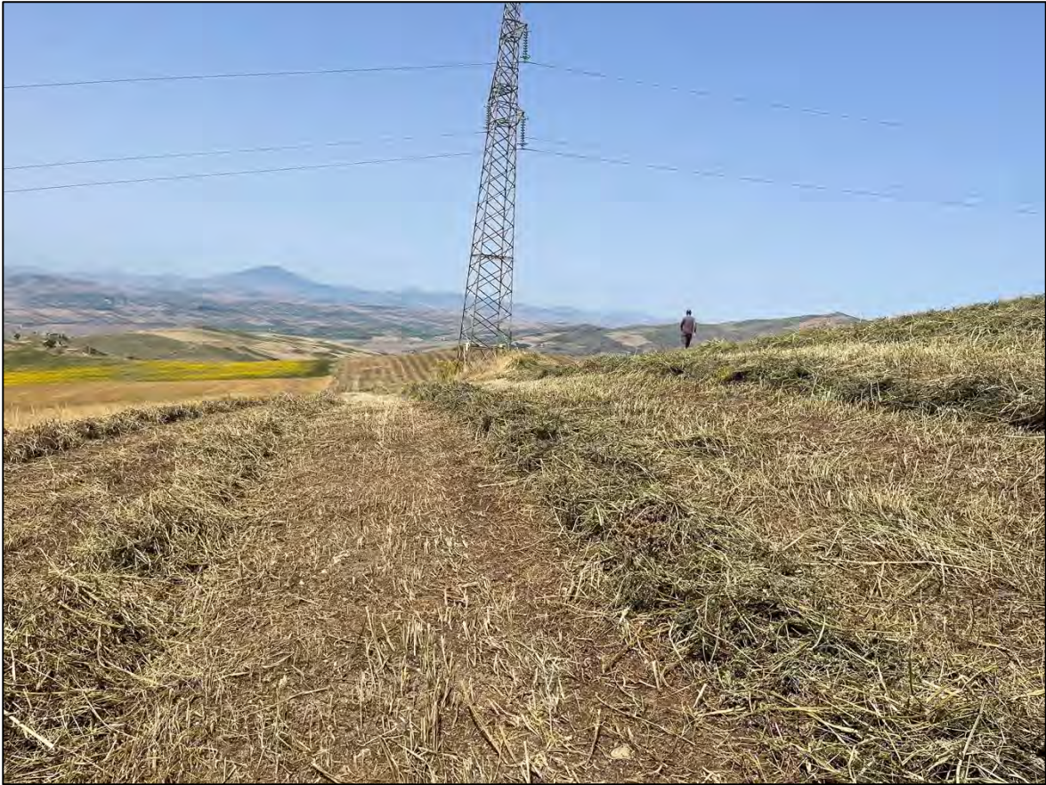
Foto 95: Panoramica UR 47 (sostegno P.15A)
