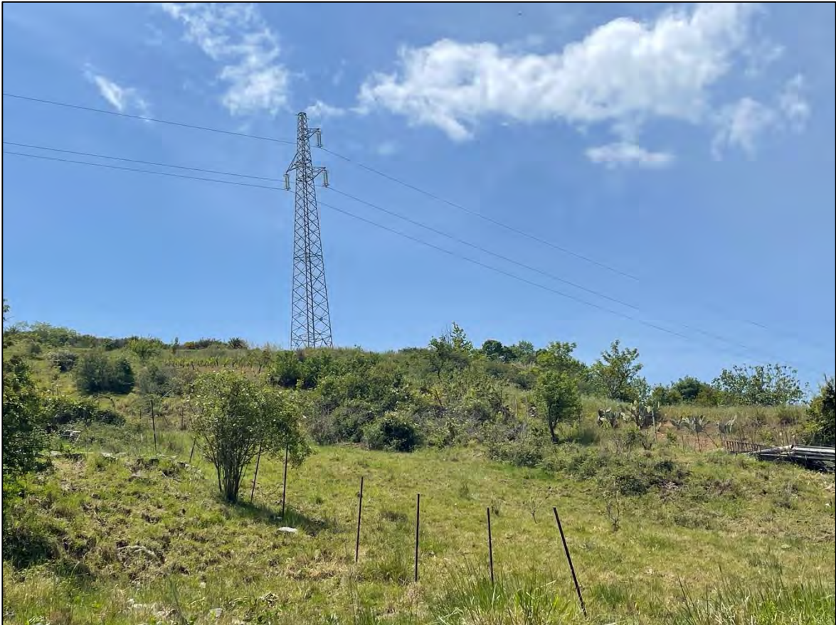
Foto 78: Panoramica UR 35 (sostegno P.338A)
