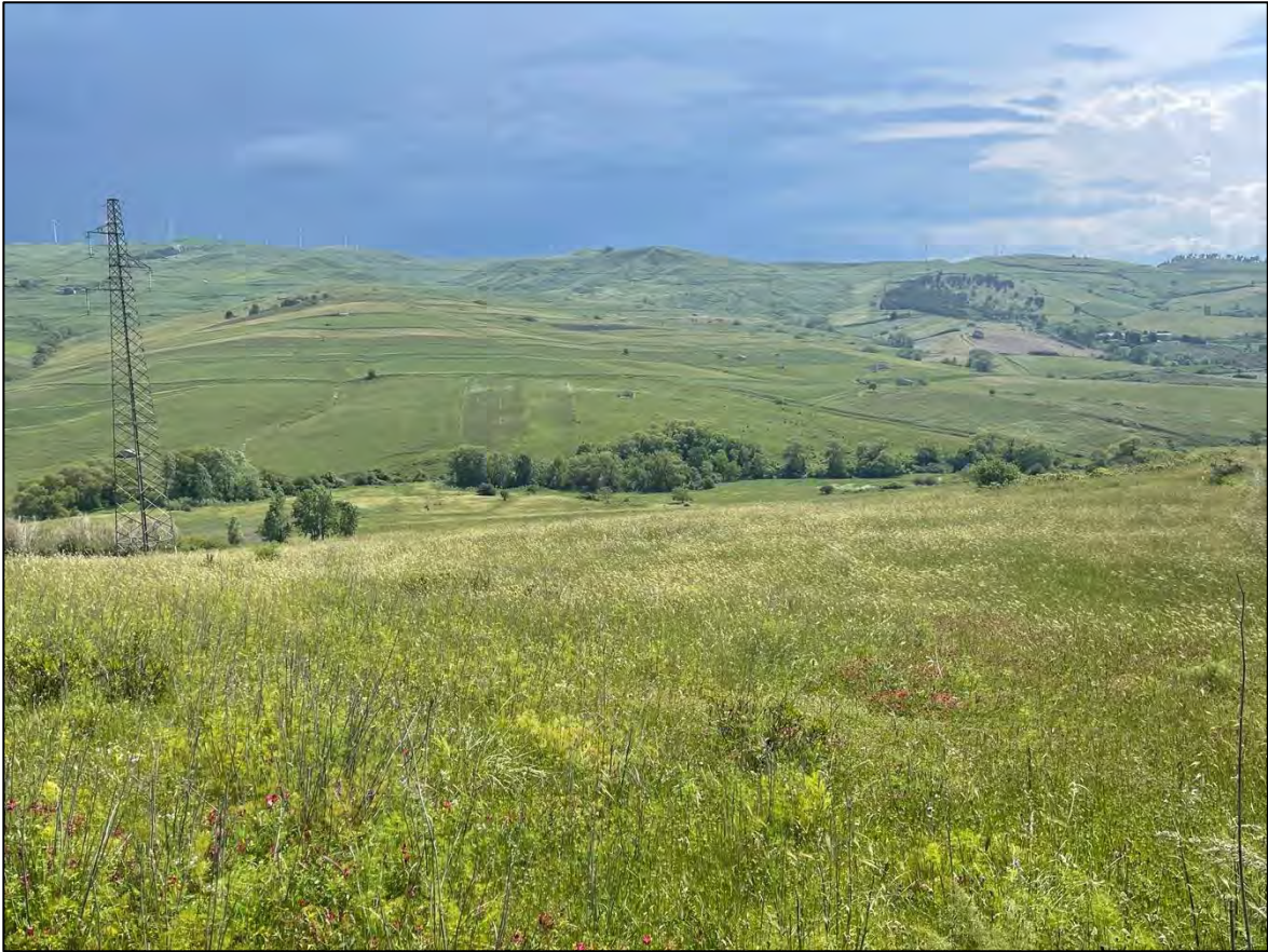
Foto 85: Panoramica UR 39 (sostegno P.331A)
