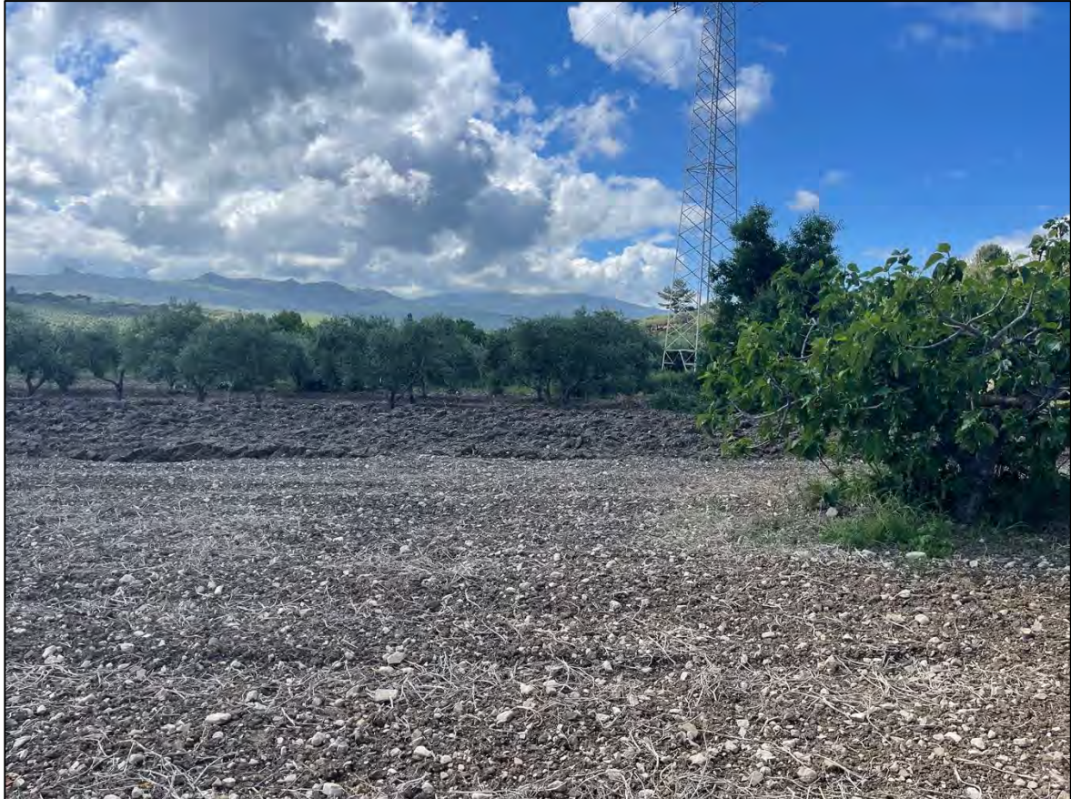
Foto 44: Panoramica UR 10 (sostegno P.376A)
