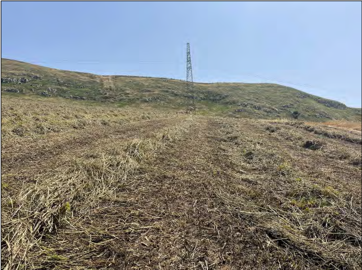
Foto 96: Panoramica UR 47 (sostegno P.15A)
