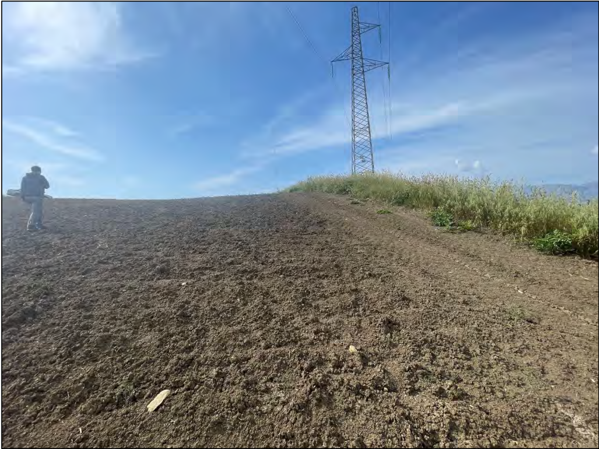
Foto 89: Panoramica UR 42 (sostegno P.6A)
