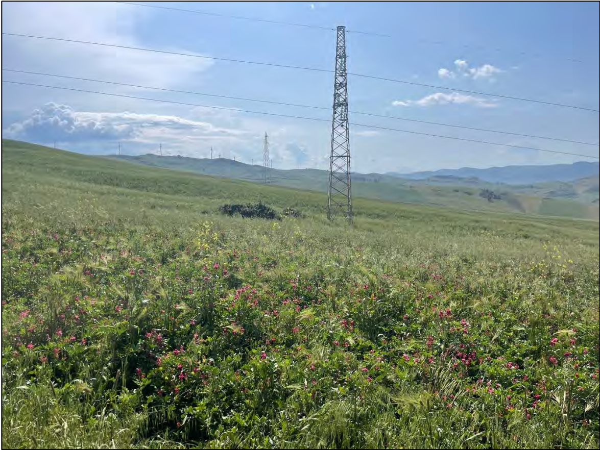
Foto 87: Panoramica UR 41 (sostegno P.4A)
