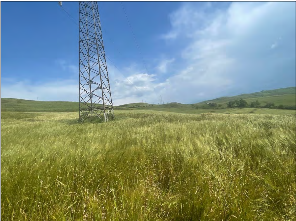
Foto 86: Panoramica UR 40 (sostegno P.330A)
