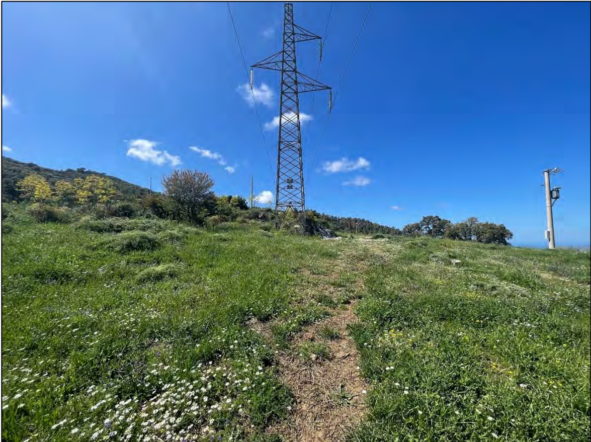
Foto 66: Panoramica UR 26 (sostegno P.356A)
