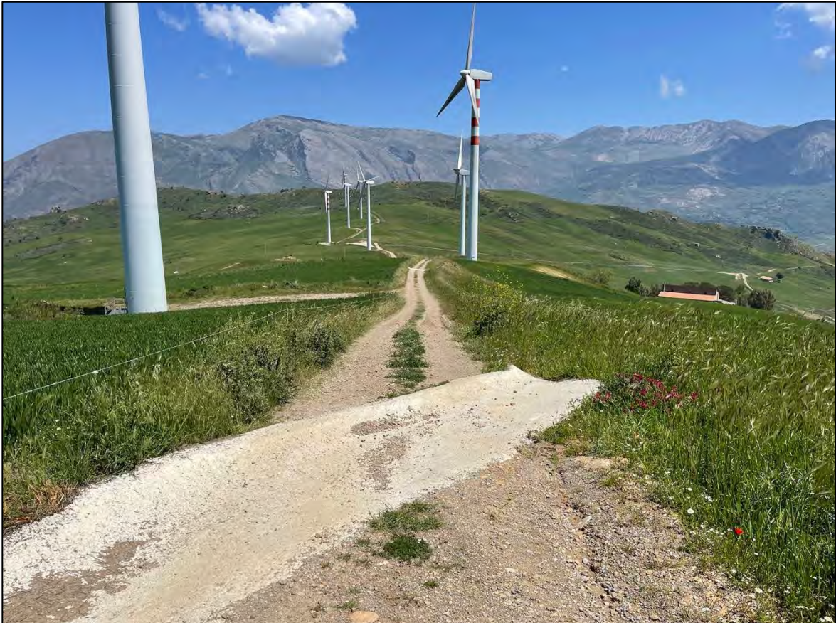
Foto 12: Panoramica UR 03 (viabilità e cavidotti)
