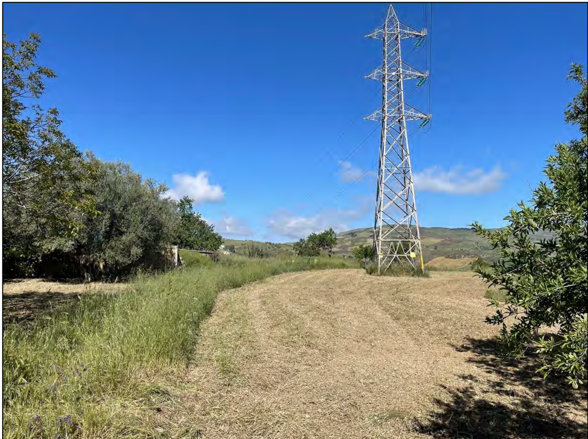
Foto 114: Panoramica UR 64 (sostegno P.55A)
