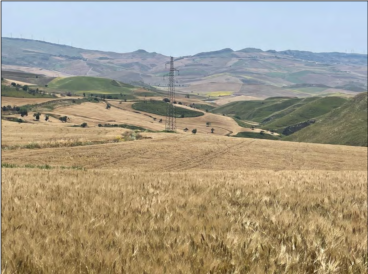
Foto 102: Panoramica UR 53 (sostegno P.24A)
