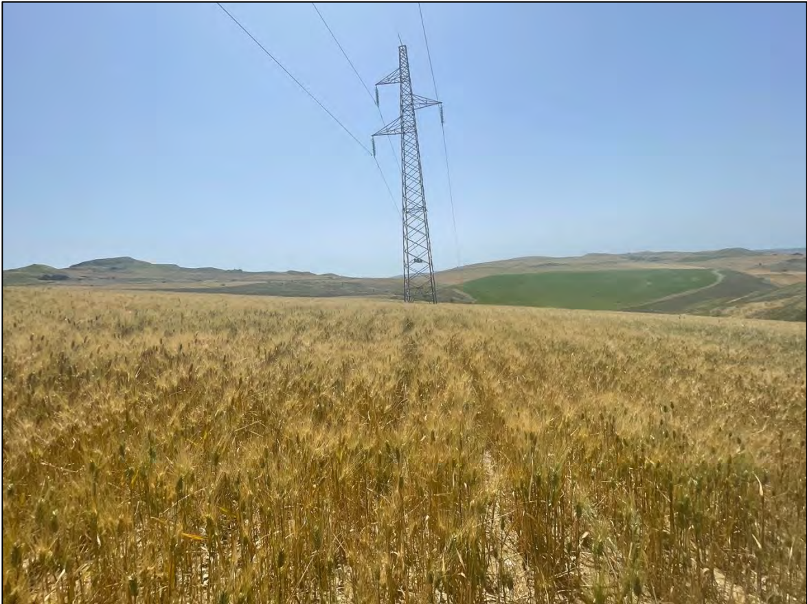
Foto 98: Panoramica UR 49 (sostegno P.17A)
