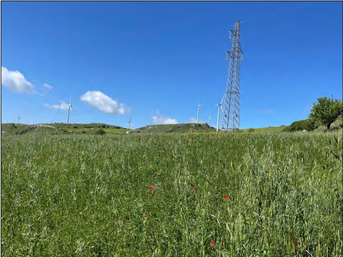
Foto 110: Panoramica UR 61 (sostegno P.41A)
