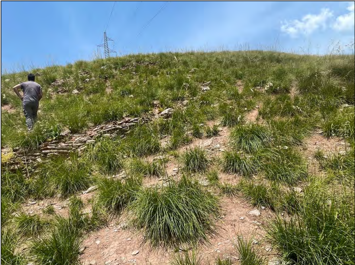
Foto 74: Panoramica UR 33 (sostegno P.339A)
