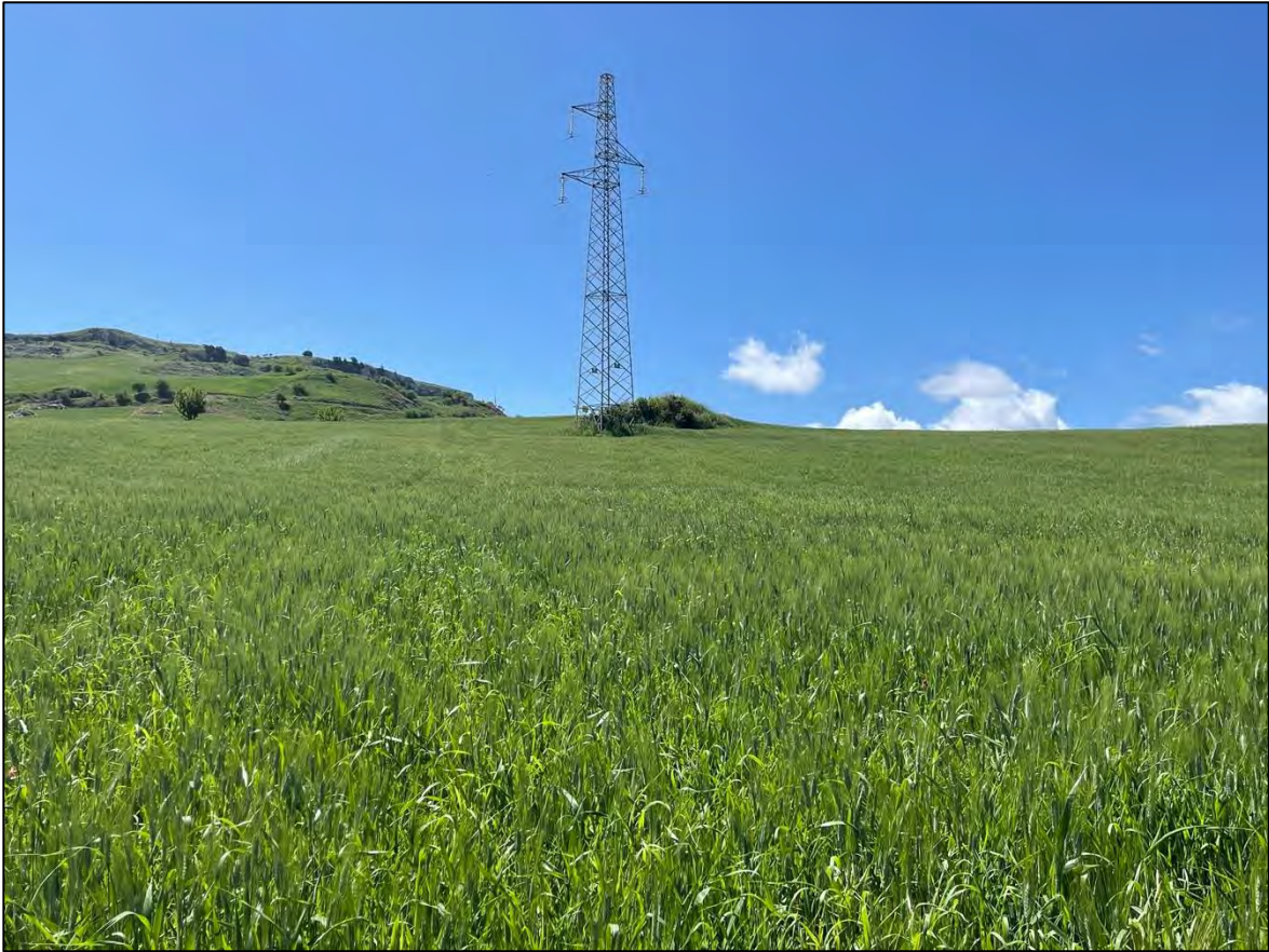
Foto 109: Panoramica UR 60 (sostegno P.38A)
