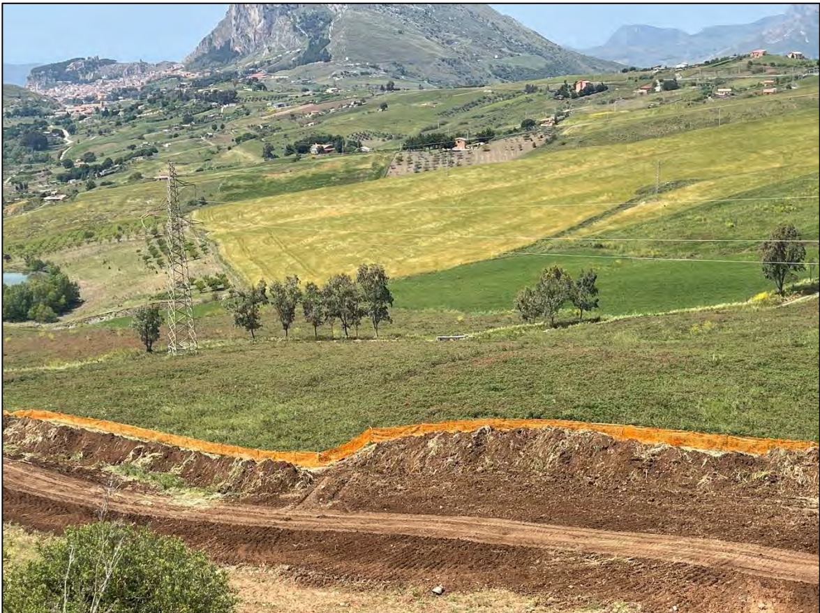
Foto 82: Panoramica UR 38 (sostegno P.334A)
