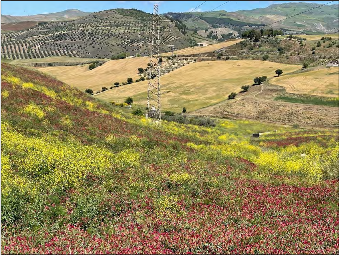
Foto 107: Panoramica UR 58 (sostegno P.34A)
