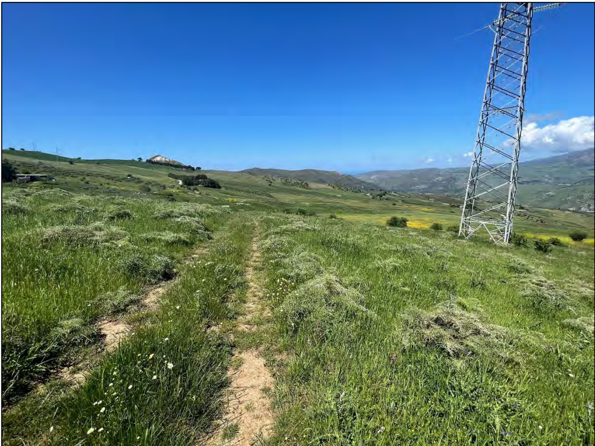
Foto 64: Panoramica UR 23 (sostegno P.359A)
