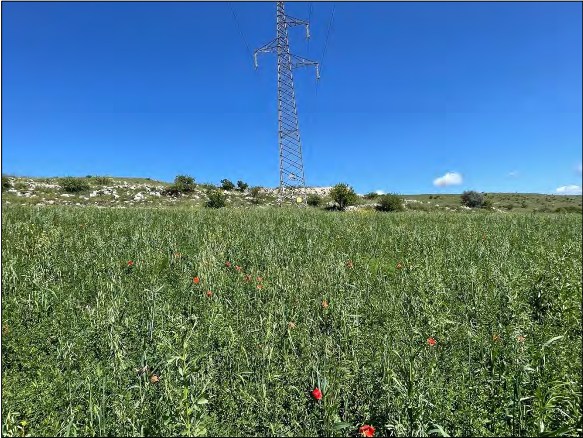
Foto 111: Panoramica UR 61 (sostegno P.41A)
