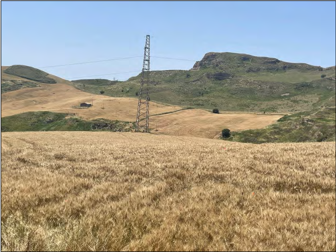
Foto 101: Panoramica UR 52 (sostegno P.23A)
