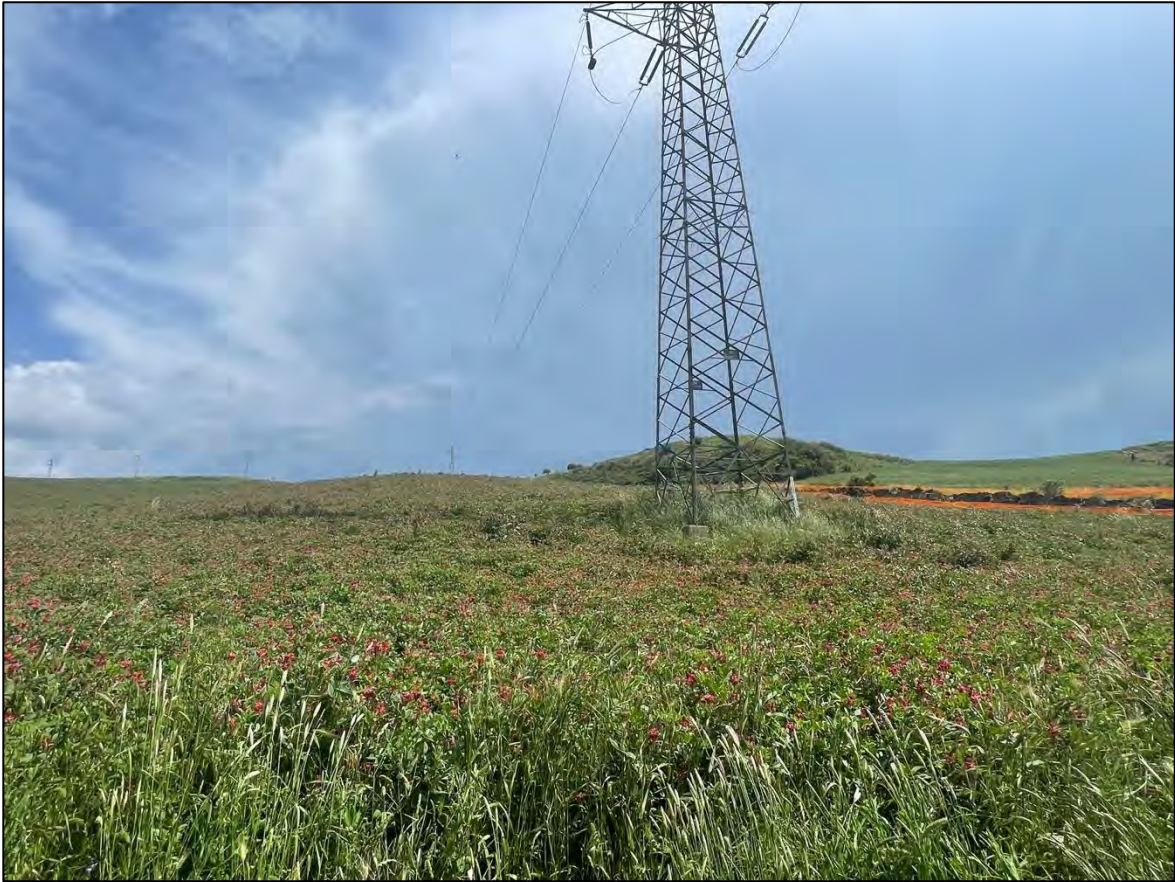
Foto 83: Panoramica UR 38 (sostegno P.334A)
