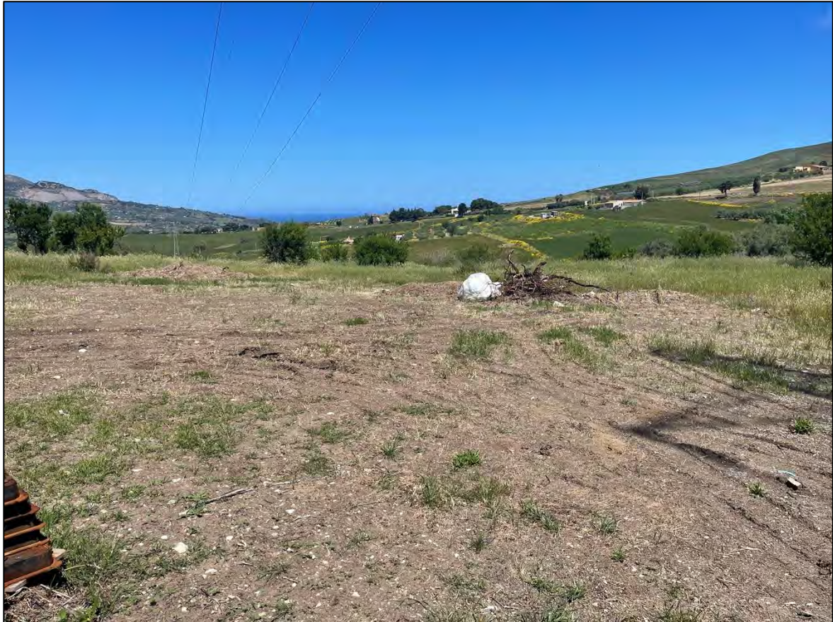
Foto 53: Panoramica UR 15 (sostegno P.370A)
