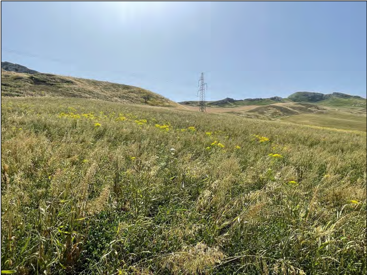
Foto 92: Panoramica UR 45 (sostegno P.11A)
