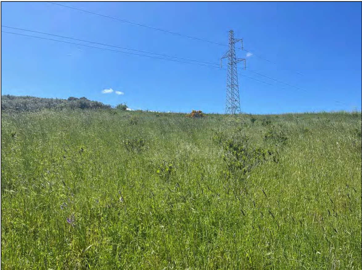
Foto 62: Panoramica UR 22 (sostegno P.360A)
