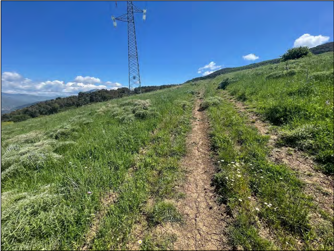
Foto 63: Panoramica UR 23 (sostegno P.359A)
