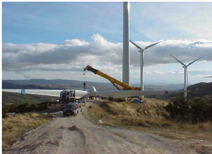
**Figura 3-3: Ingombro del rotore a terra**
