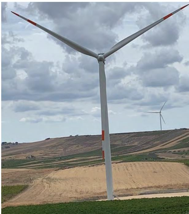
**Figura 7-5: Esempio di aerogeneratore con pale a bande rosse**
