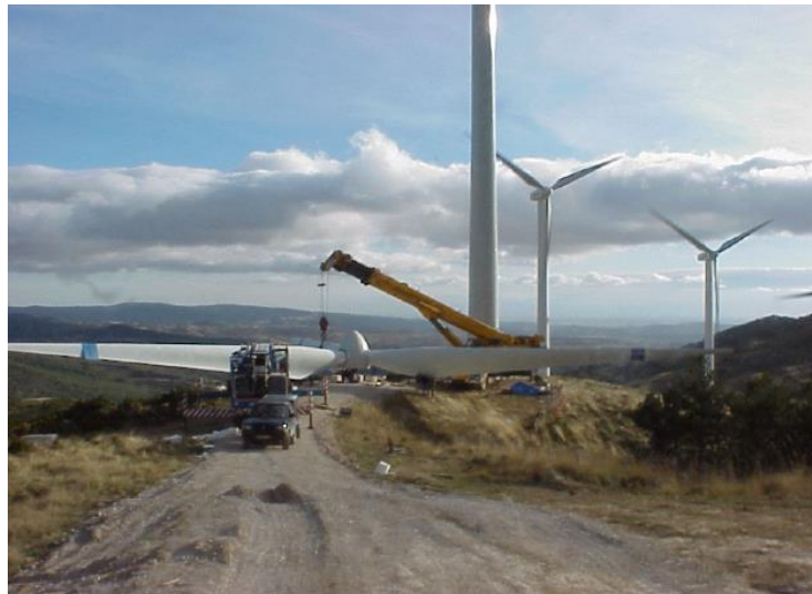
Figura 3-3: Ingombro del rotore a terra
