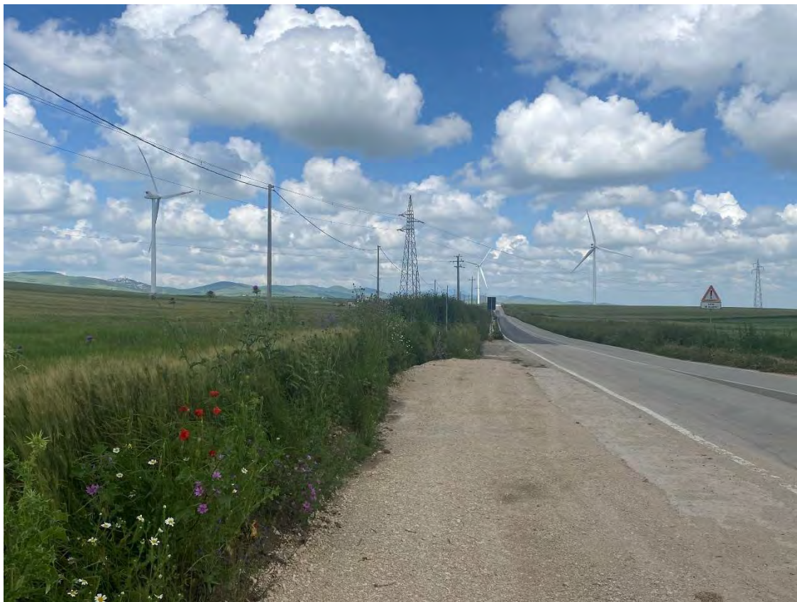
Figura 13 – Area Campo Fotovoltaico– Vista Lato Est
