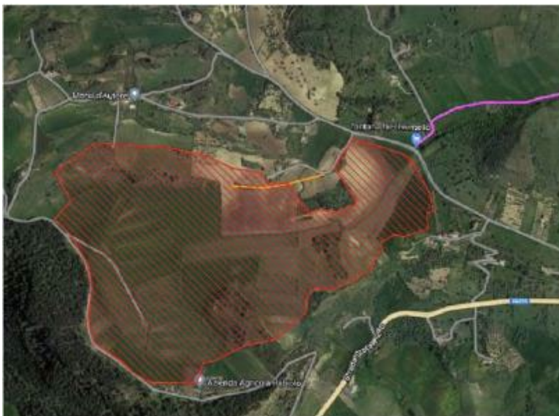
Figura 5: Area di cantiere di monte (Viabilità 1 da adeguare in magenta e Viabilità 2 da creare in Arancio)
