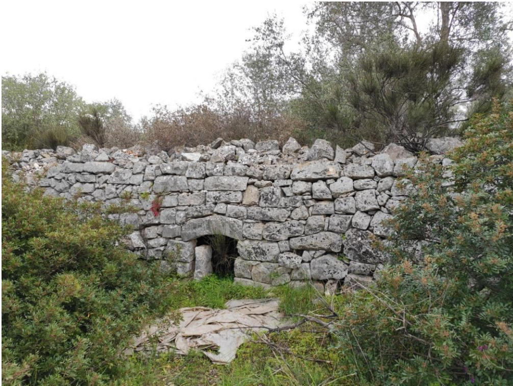
Fig. 3. Triggiano (Ba). Giannavella. Tracce di muraglioni a secco di natura mediolitica, in opera poligonale, relativa forse a una fortificazione o a un recinto antico. La datazione varia dal VII al IV sec. a.C. (si escludono gli interventi seriori, non databili, che ne hanno dimezzato l'altezza).
