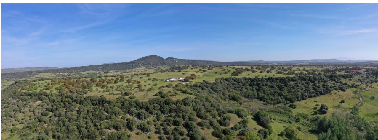
Figura 36: Immagine aerea dell'area interessata
