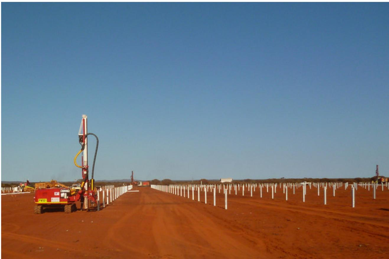
**Figura 58-59-60: Dettagli ed infissione sostegno a mezzo di battipalo**
