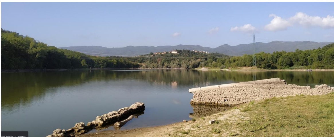
Figura 12 – foto dalla sponda della Diga di Santa Barbara o San Cipriano (fonte Google Earth)
