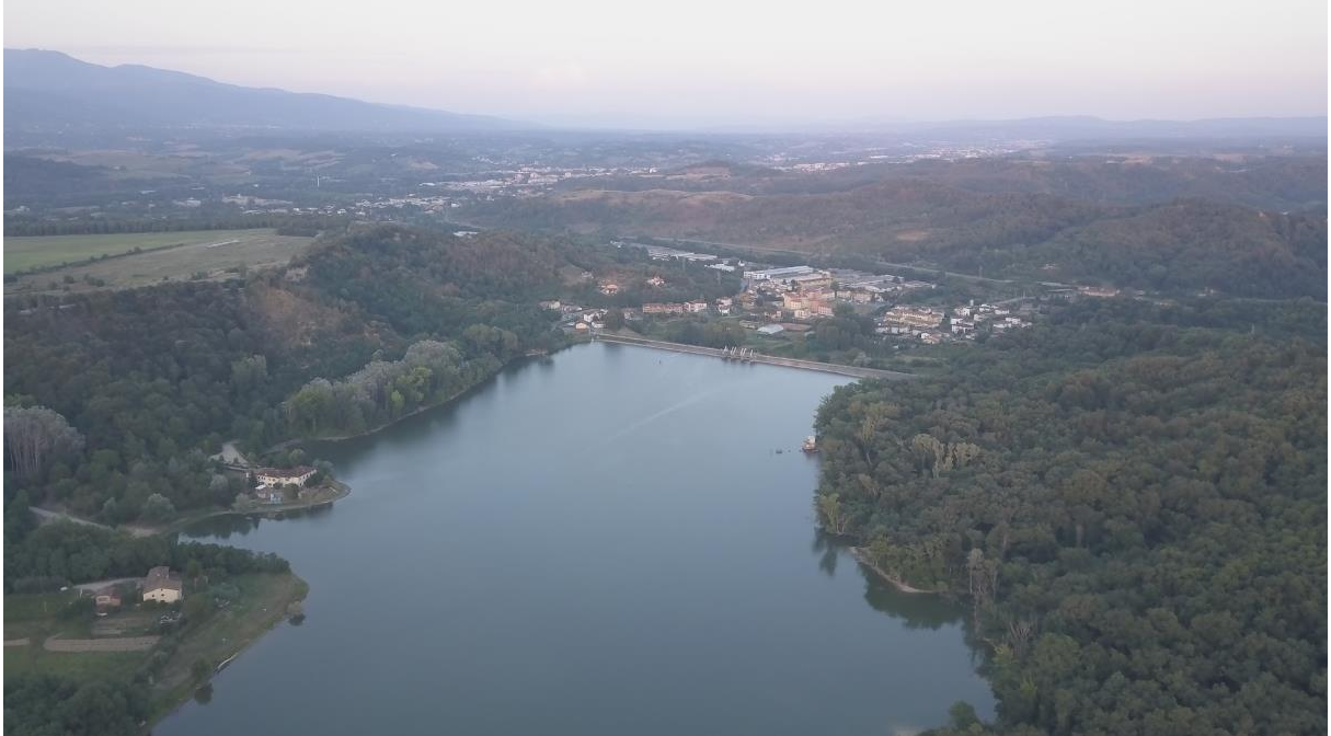
Figura 13 – Foto aerea della Diga di Santa Barbara o San Cipriano (fonte Google Earth)
