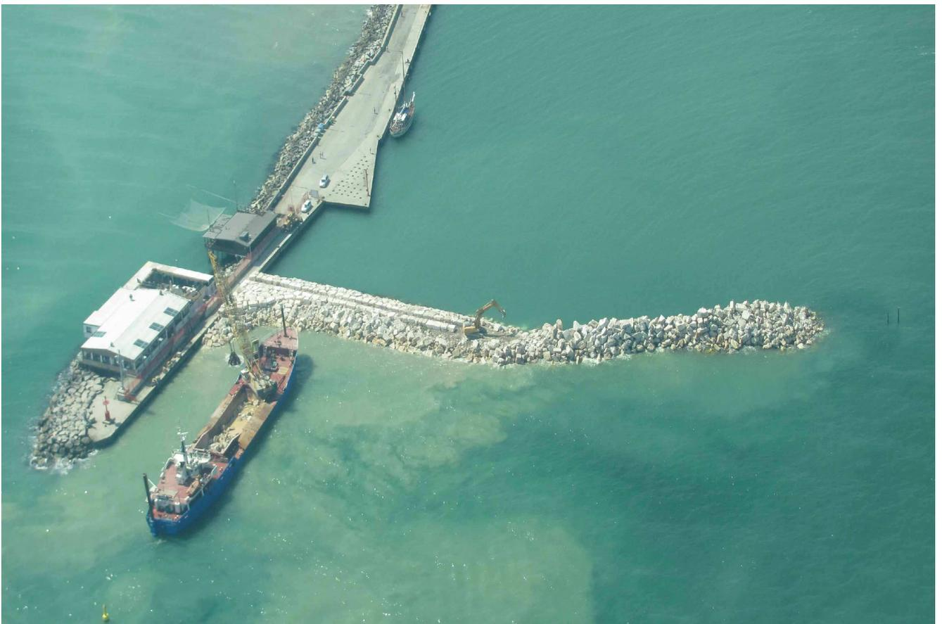
Figura 4 La fotografia scattata dall'aereo il 25 maggio 2011 mostra il nuovo pennello all'imboccatura del porto di Rimini in avanzata fase di costruzione
