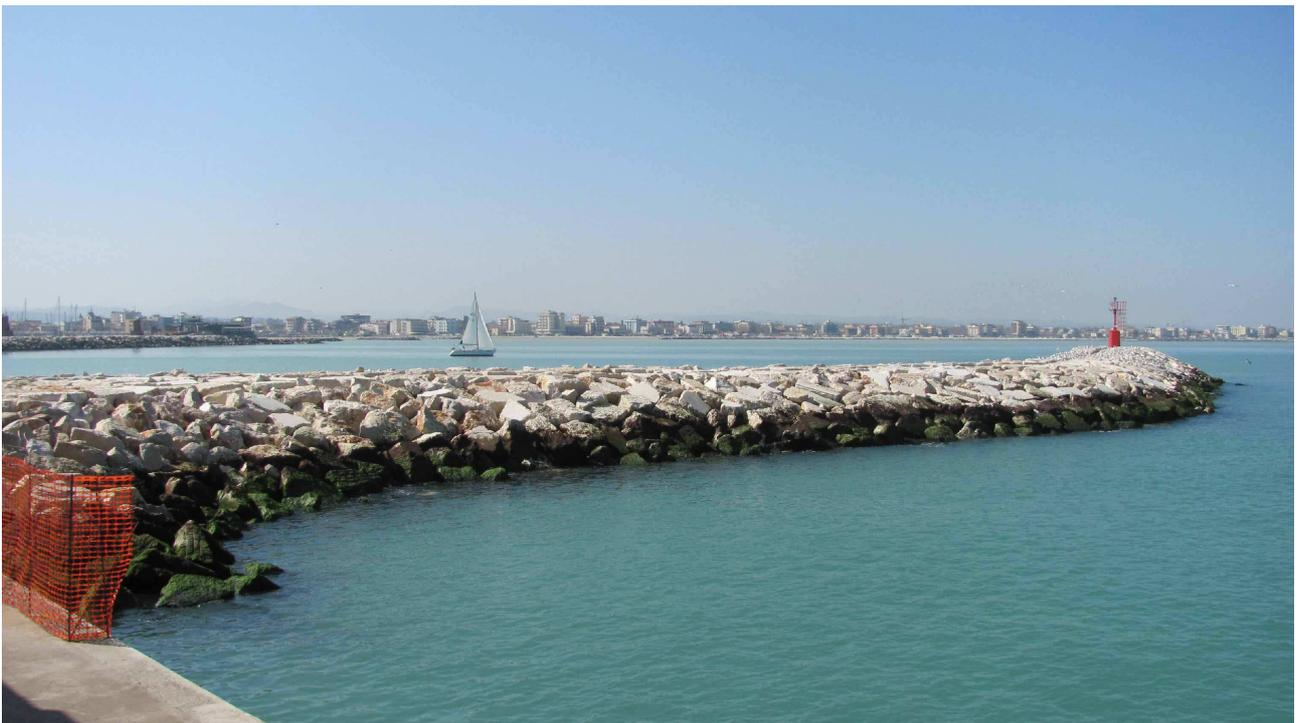
Figura 19 Foto a terra del nuovo pennello trasversale del porto di Rimini.
