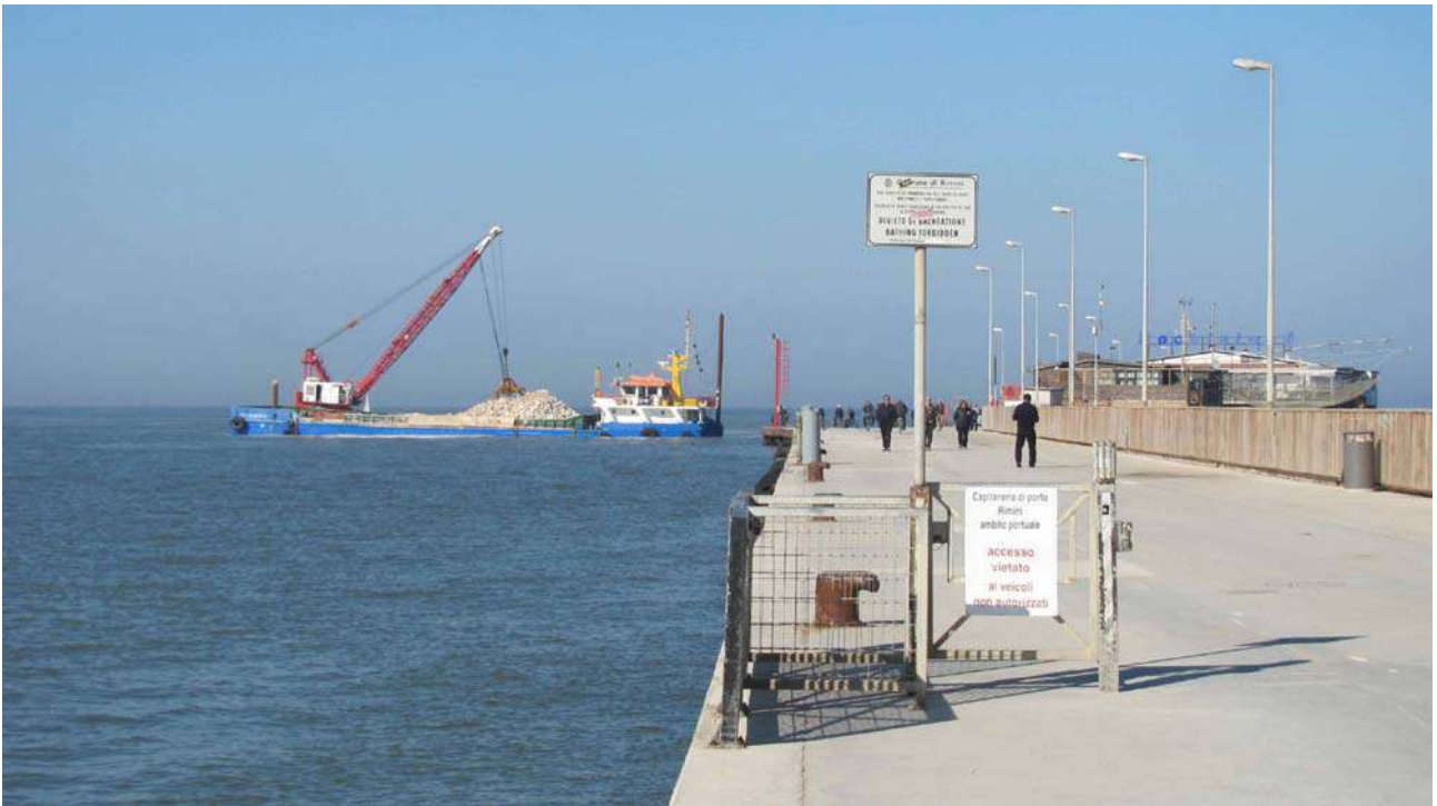
Figura 4 Porto canale di Rimini: fasi iniziali di costruzione della nuova scogliera tramite pontone e gru (25 marzo 2011)
