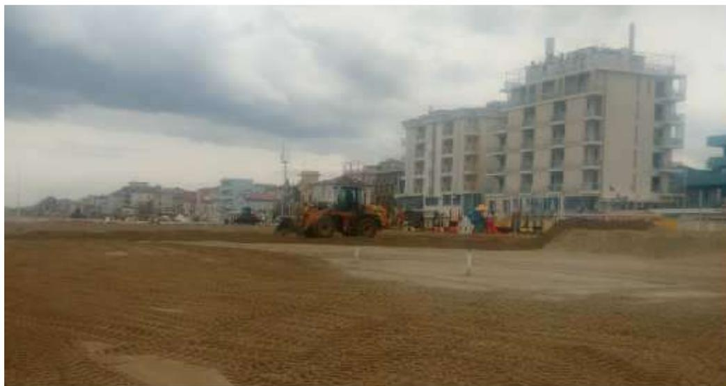
Figura 1 Rimini, Marzo 2018: operazioni di spianamento dell'argine invernali (Surveying Systems, 2018).
